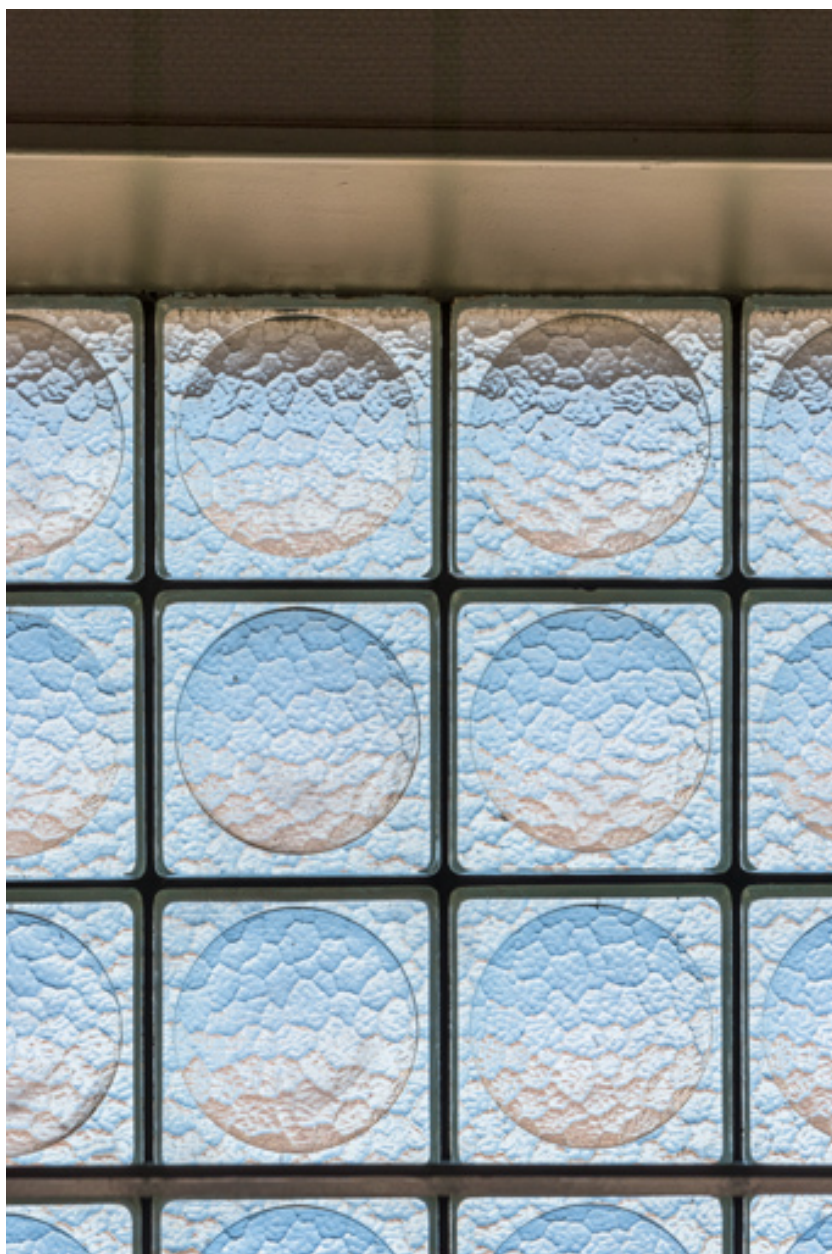
Cage d'escalier : détail des pavés de verre.
