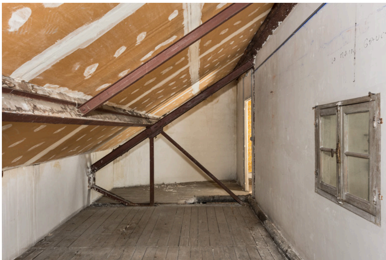
2e étage : charpente métallique.
