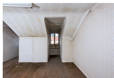
2e étage : grand bureau. Phot. Pierre-Marie Barbe-Richaud IVR26_20238900610NUC4A
