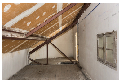
2e étage : charpente métallique. Phot. Pierre-Marie Barbe-Richaud IVR26_20238900609NUC4A
