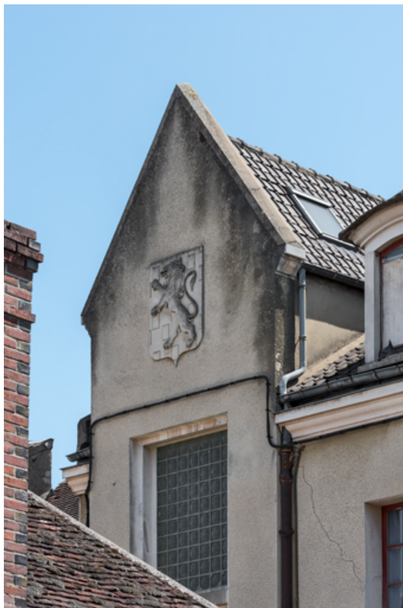
Pignon sculpté de la cage d'escalier.
