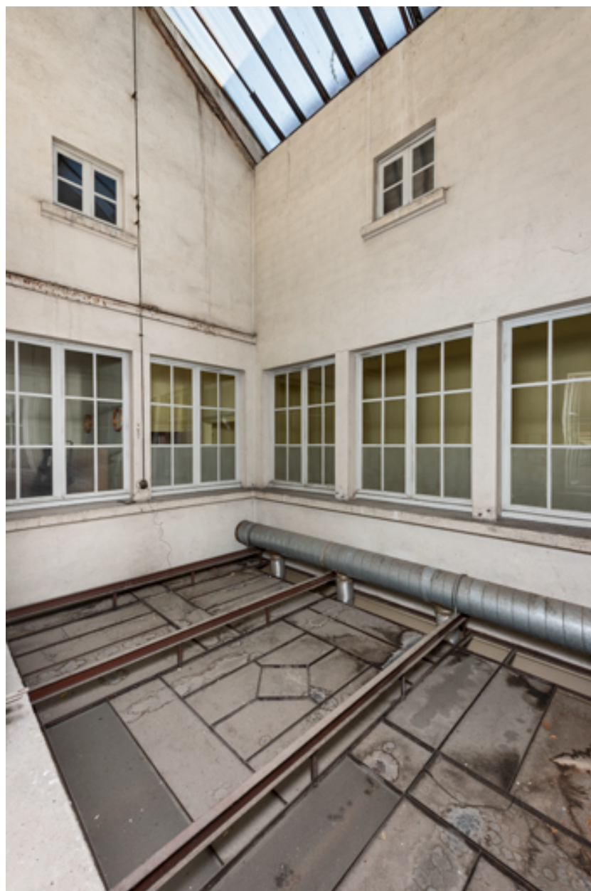
Puits de lumière au 1er étage.
