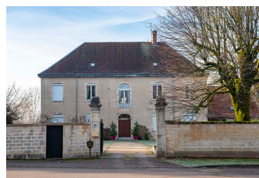
La façade antérieure et le portail d'entrée. Phot. Jérôme Mongreville IVR43_20197000095NUC4A
