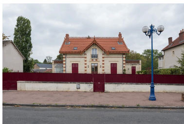
Façade principale, vue de face. Phot. Pierre-Marie Barbe-Richaud IVR26_20205800630NUC4A
