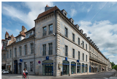
Vue d'ensemble depuis l'intersection des rues des Granges et de la République. Phot. Jérôme Mongreville IVR43_20182500862NUC4A
