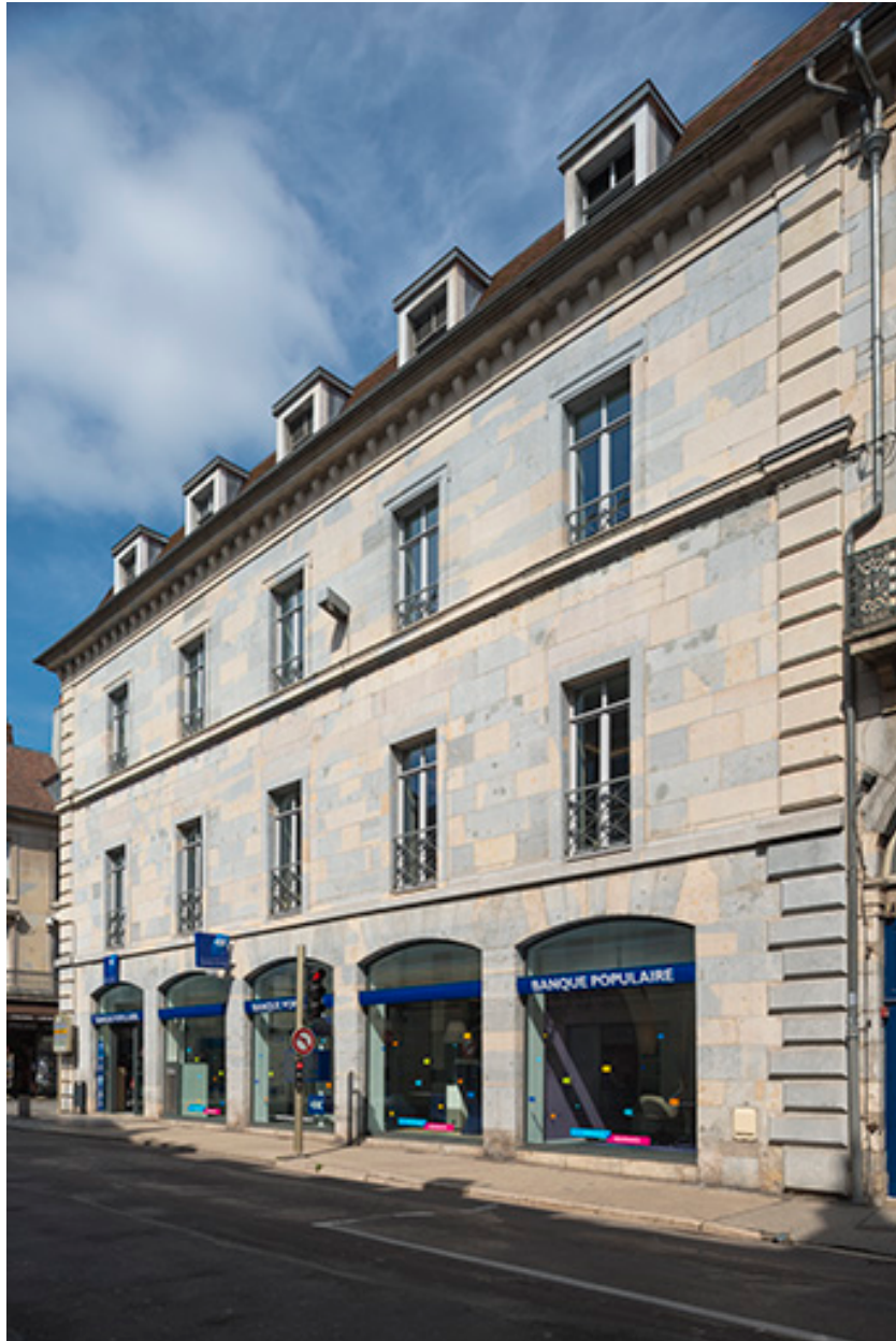
Façade rue de la République, vue de trois quarts droite.
