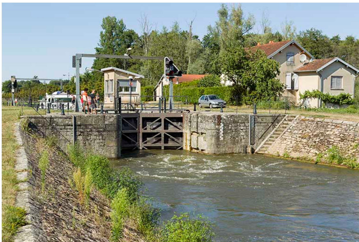
L'écluse depuis l'aval.
