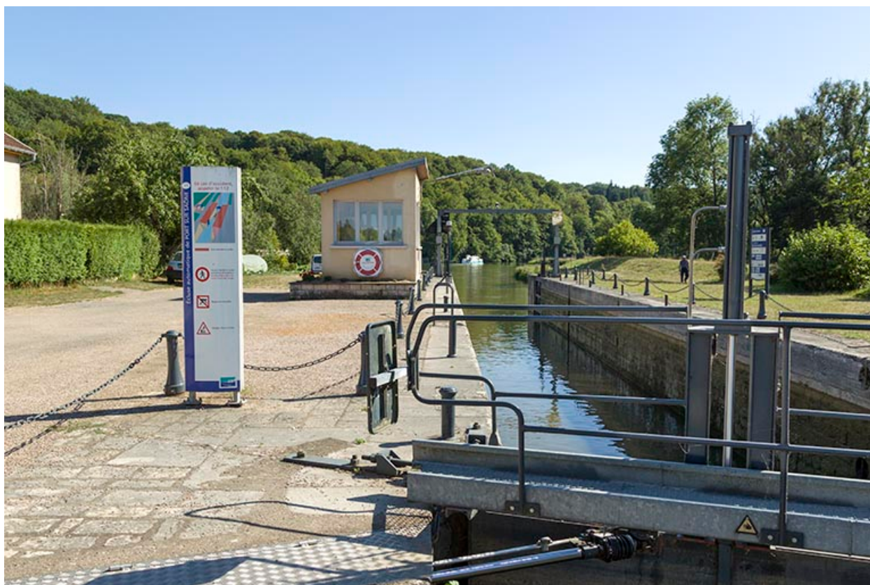
L'écluse et le poste de commande.
