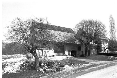
Vue d'ensemble. Phot. Bernard Lardière IVR43_19829000242Z
