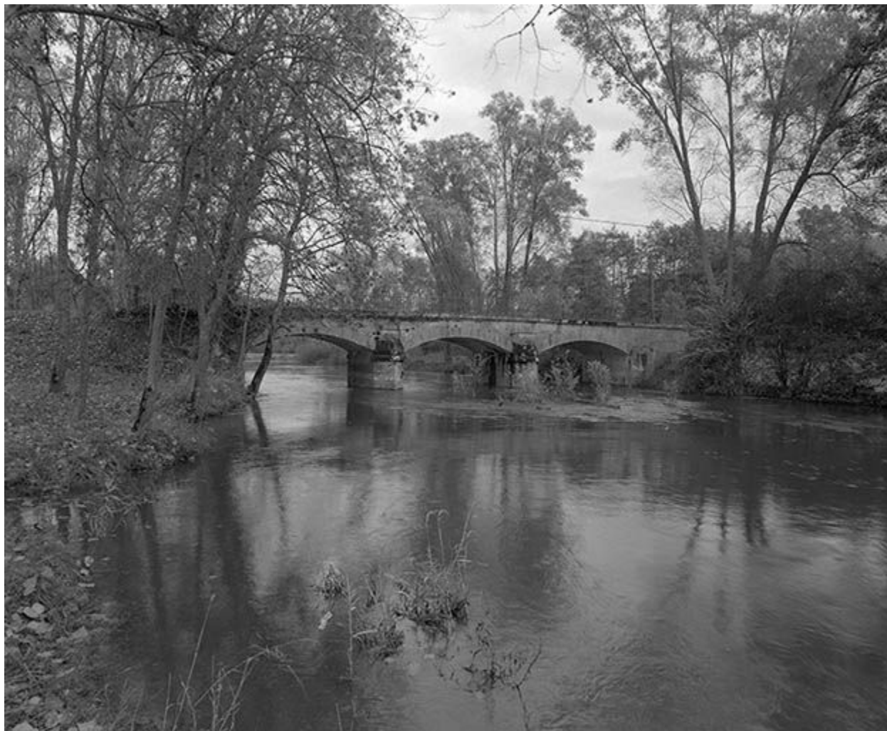
Vue prise depuis l'amont
