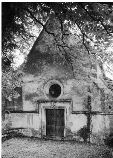
Façade de la chapelle Saint-Denis. Phot. Michel Thierry IVR26_19802100623V
