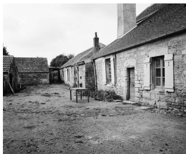
Vue d'ensemble des bâtiments actuels. Phot. Michel Rosso IVR26_19802100637X
