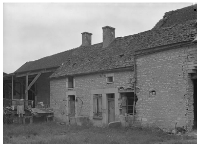
Maison et puits adossé à la façade.
