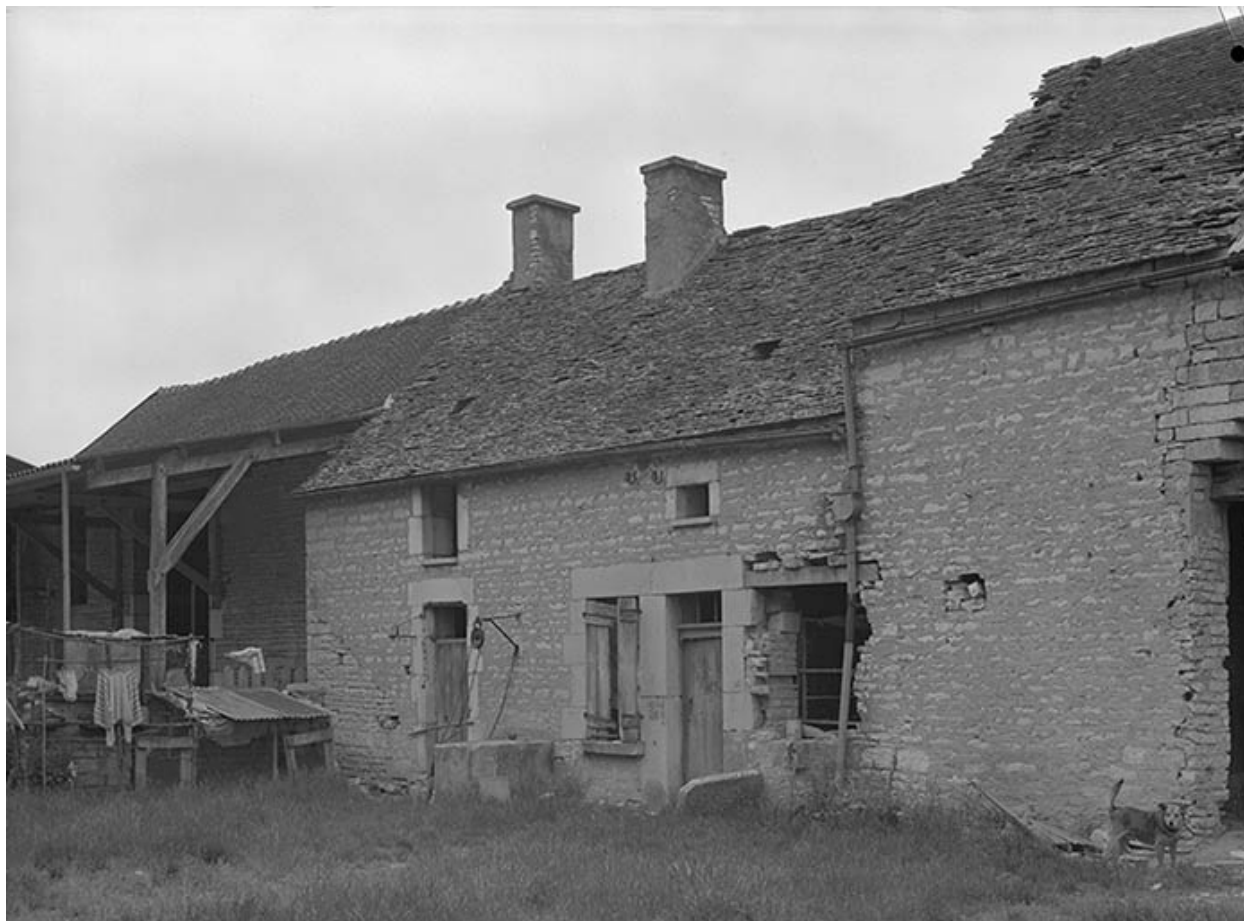
Maison et puits adossé à la façade.
