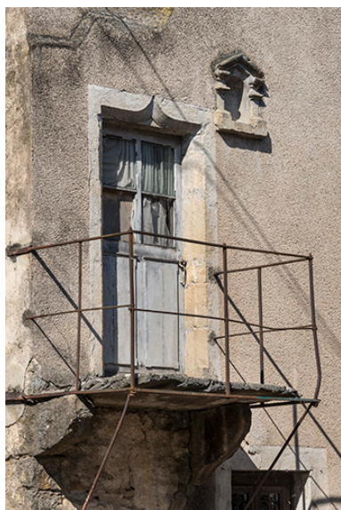
Détail de la porte en accolade. Phot. Jérôme Mongreville IVR43_20177001277NUC4A
