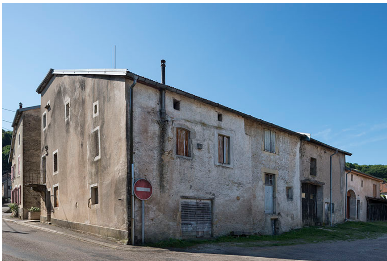
Vue depuis le nord.
