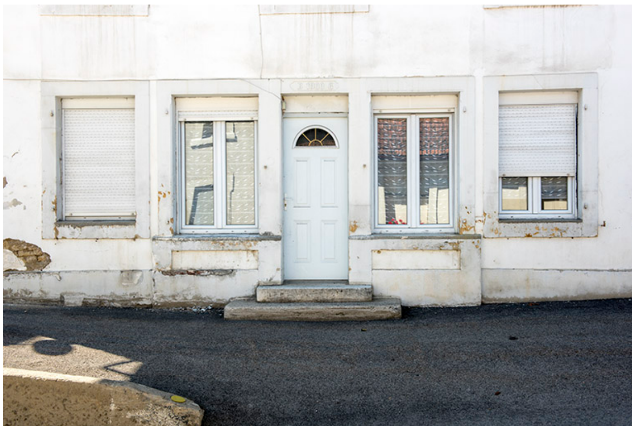
Façade antérieure : baies de l'étage de soubassement.
