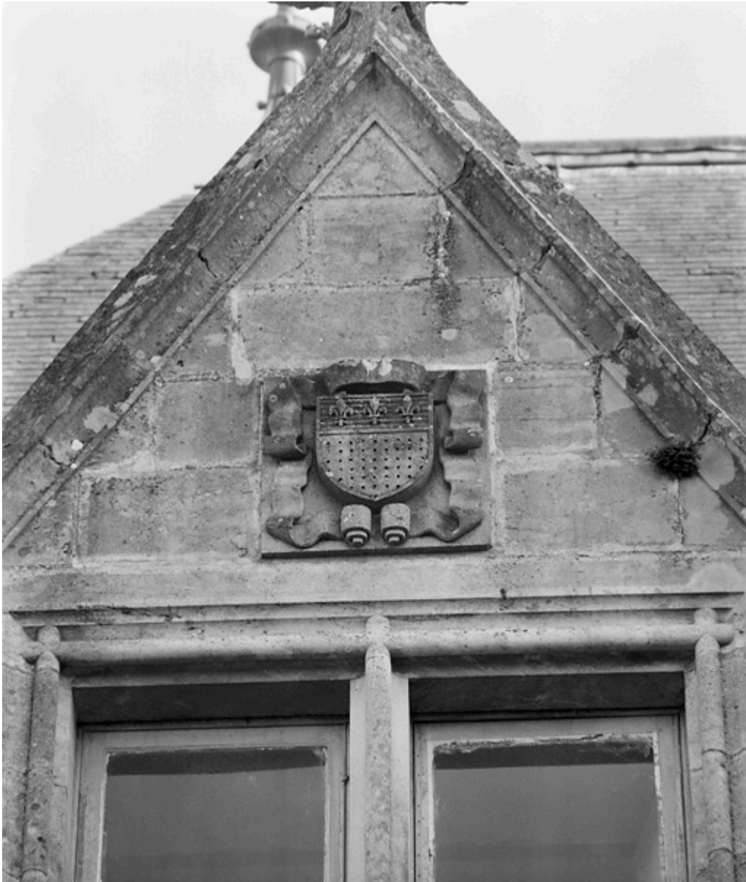
Détail des armoiries sur le corps de logis, le long de la route.
