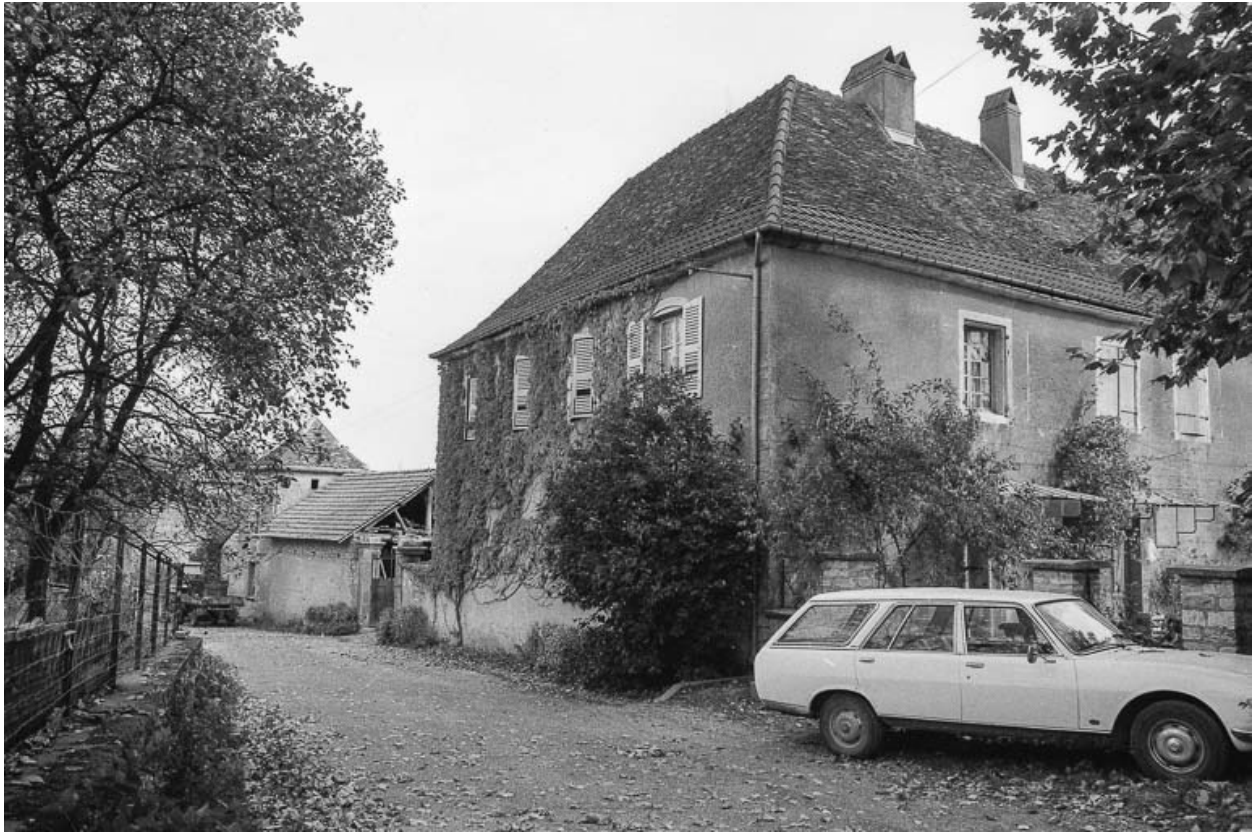
Façades latérale droite et postérieure.
