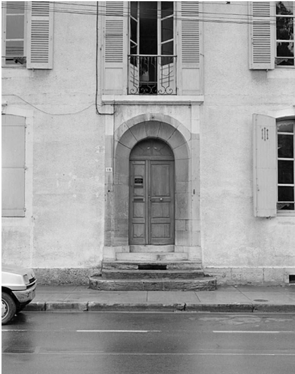
Façade antérieure, porte d'entrée.
