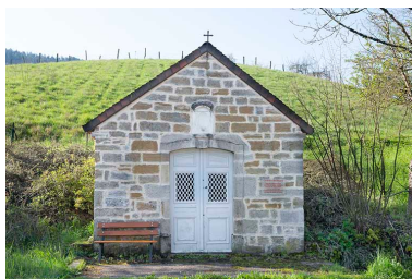
Vue de face. Phot. Jérôme Mongreville IVR43_20233900268NUC4A
