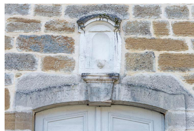
Partie supérieure de la porte. Phot. Jérôme Mongreville IVR43_20233900269NUC4A
