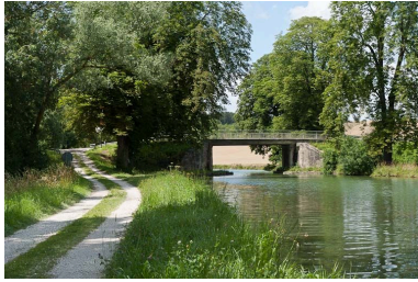
Vue du pont.
