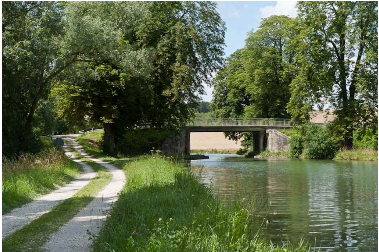
Vue du pont.
