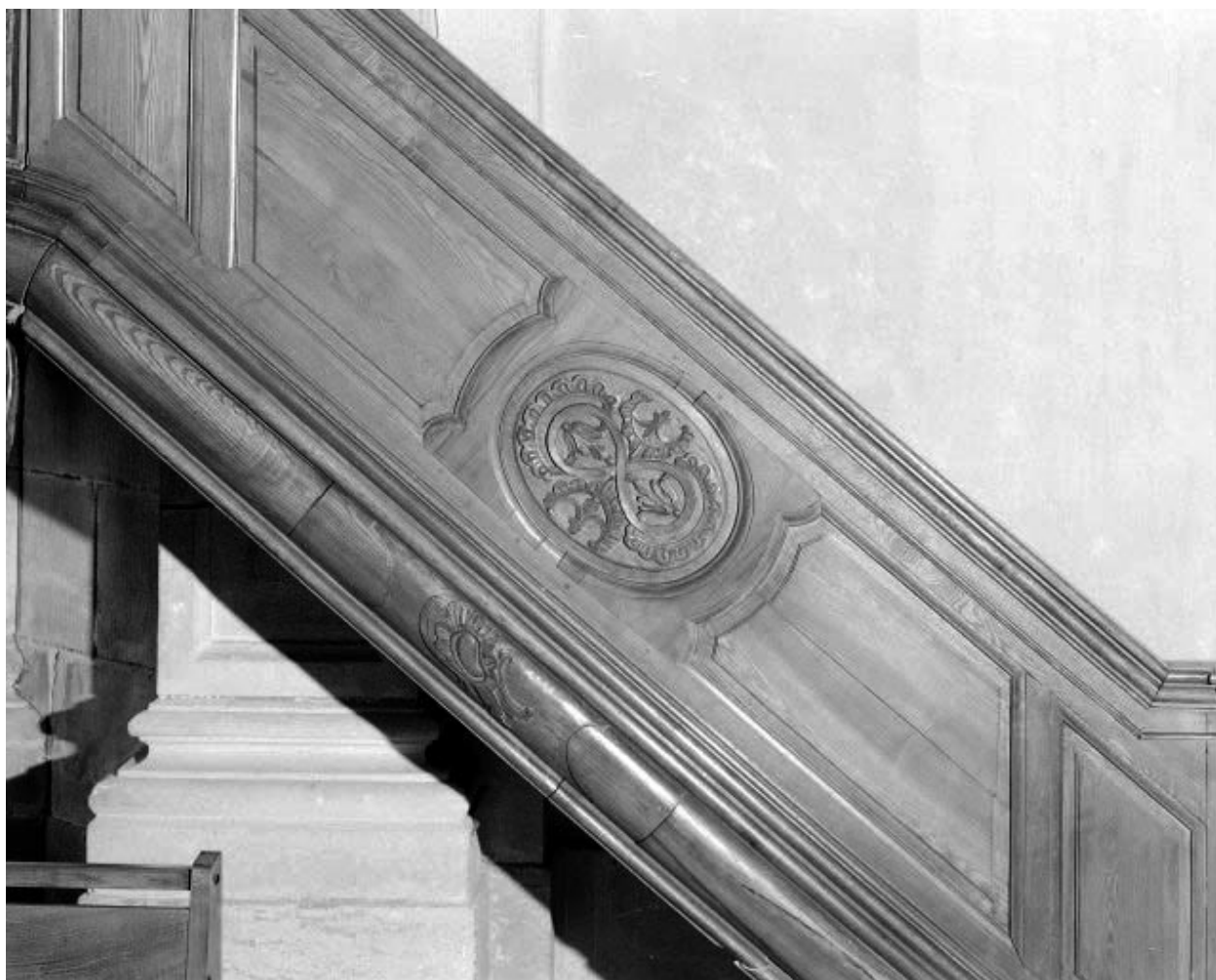
Détail : la rampe.
