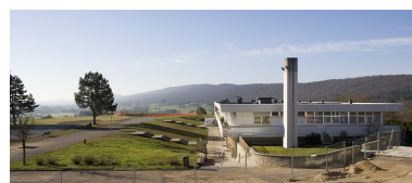
Crotenay, lycée d'enseignement adapté : vue d'ensemble. Phot. Yves Sancey IVR43_20063900422NUCA
