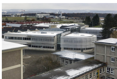
Montbéliard, lycée Jules Viette : vue d'ensemble depuis la tour d'internat. Phot. Yves Sancey IVR43_20072500999NUCA
