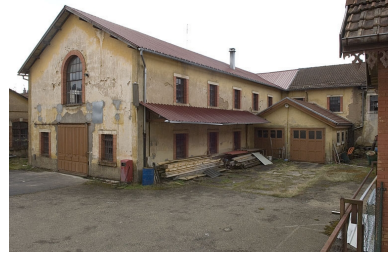
Bureaux. Phot. Jérôme Mongreville IVR43_20067000153NUCA
