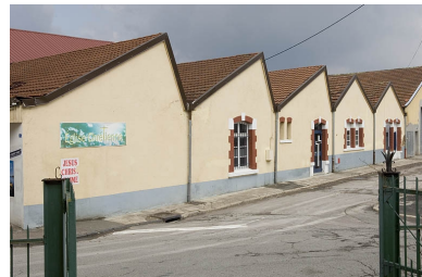
Murs-pignons est de l'usine. Phot. Jérôme Mongreville IVR43_20067000151NUCA
