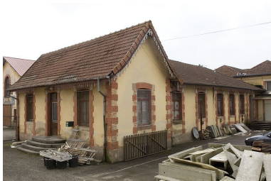
Bâtiments techniques. Phot. Jérôme Mongreville IVR43_20067000152NUCA
