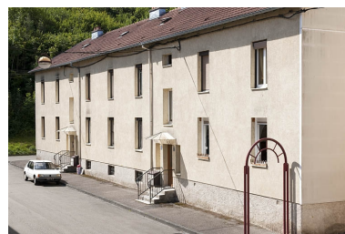
Vue de trois quarts d'une habitation. Phot. Jérôme Mongreville IVR43_20112502192NUC4A
