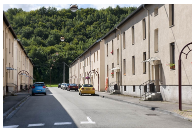
Vue d'ensemble d'une rue de la cité. Phot. Jérôme Mongreville IVR43_20112502190NUC4A
