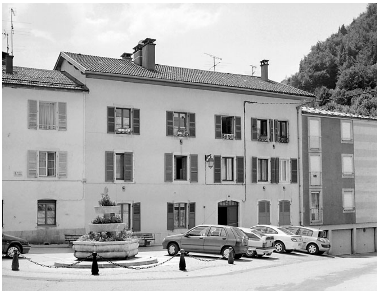
Elévation antérieure, de trois quarts gauche.
