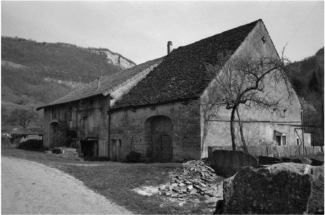
Façades antérieure et latérale droite en 1974.
