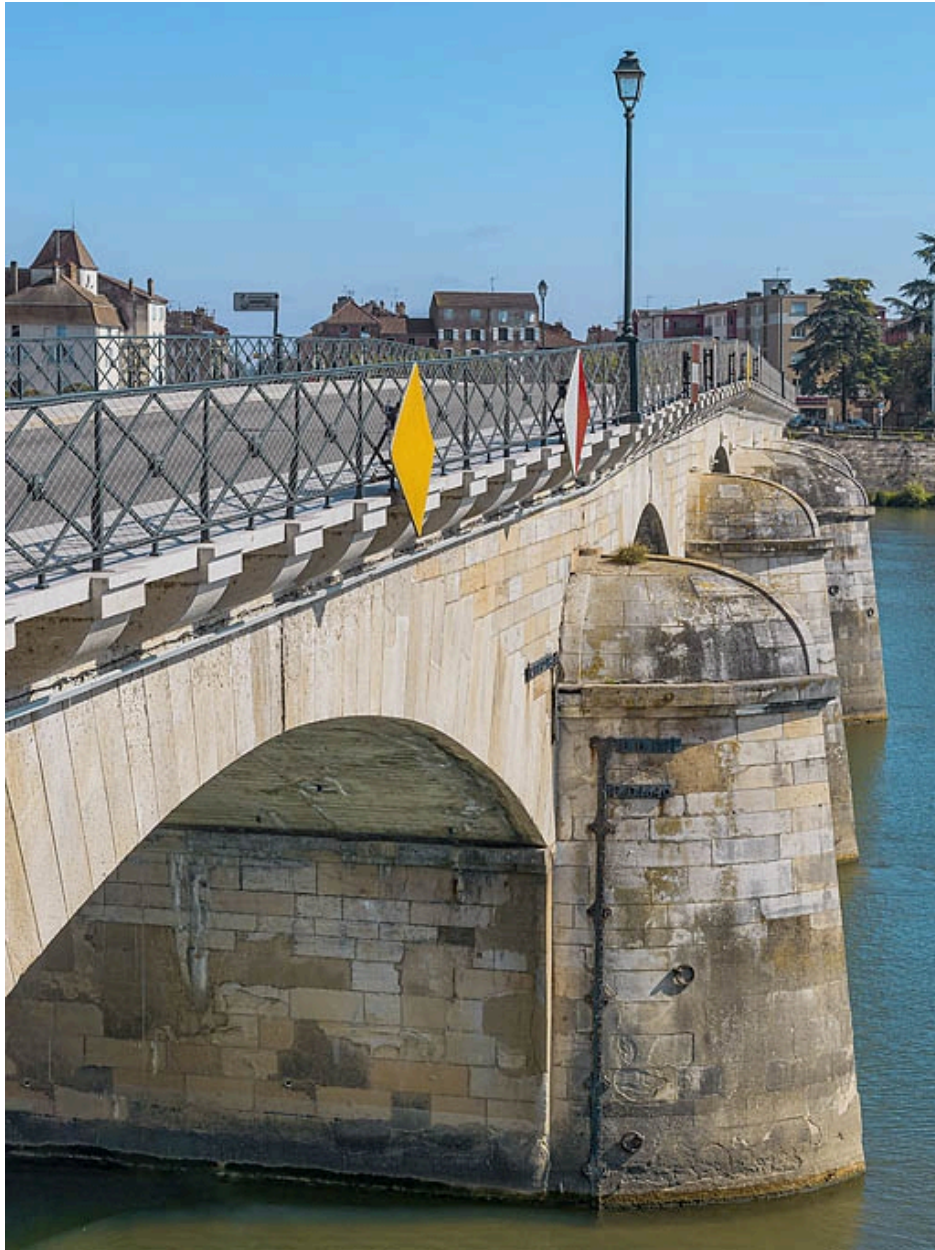
Détail des arrière-becs du pont.
