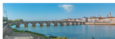
Le pont Saint-Laurent, vu d'amont, depuis la rive gauche. Phot. Thierry Kuntz IVR26_20217100554NUC4A
