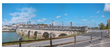
Vue d'ensemble du pont, d'aval et depuis la rive gauche. Phot. Thierry Kuntz IVR26_20217100558NUC4A
