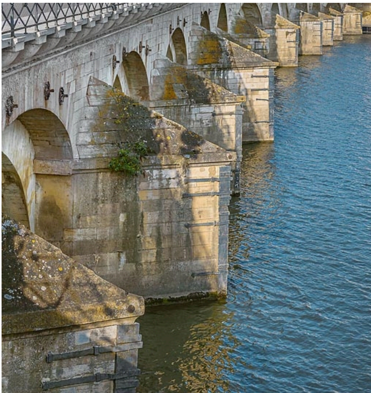
Les avant-becs du pont Saint-Laurent.
