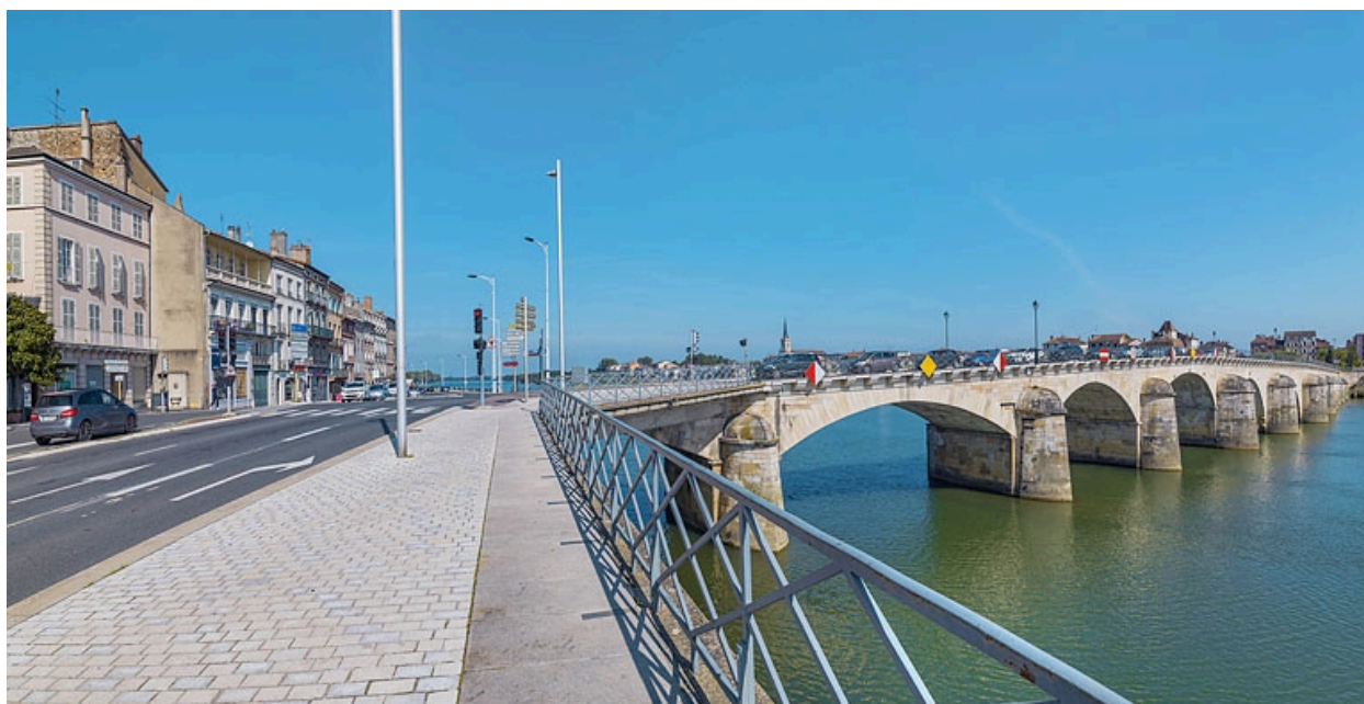
Le pont Saint-Laurent, vu d'aval, rive droite.
