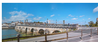
Vue d'ensemble du pont, d'aval et depuis la rive gauche. Phot. Thierry Kuntz IVR26_20217100559NUC4A
