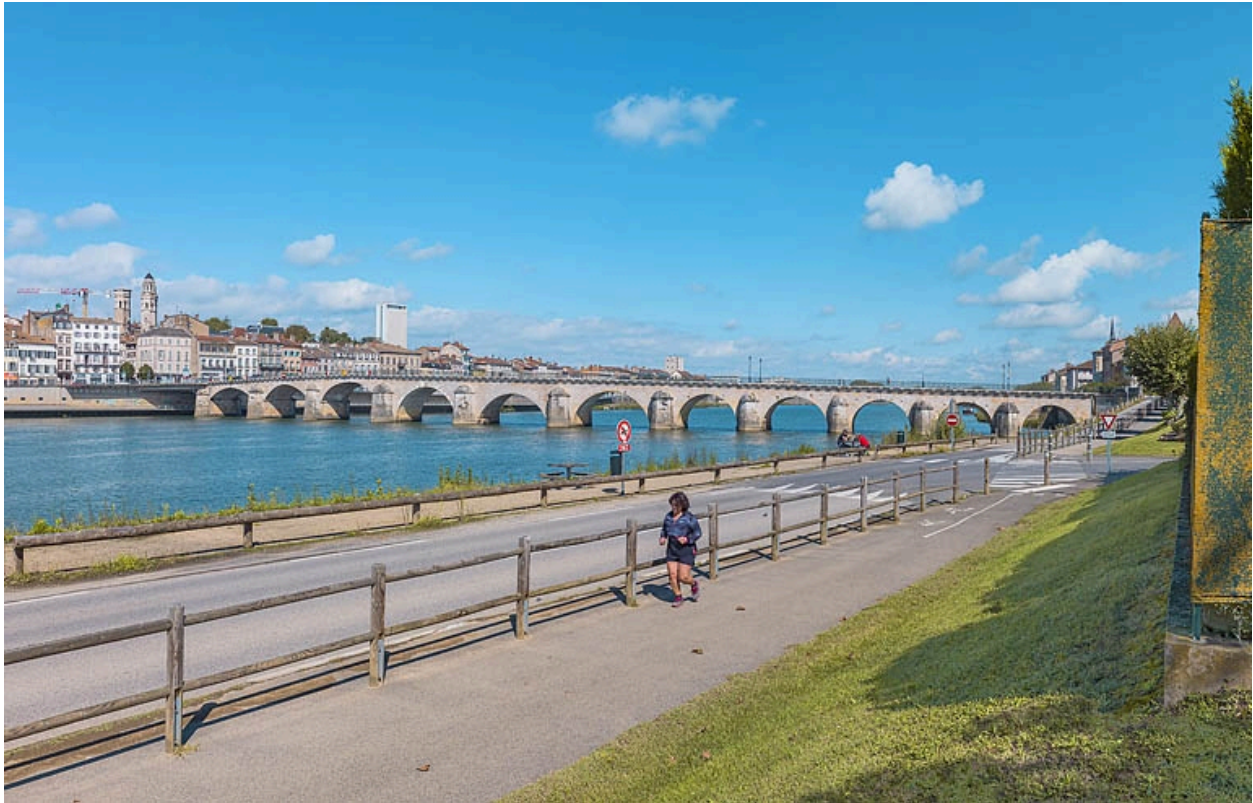
Vue d'ensemble du pont, d'aval et depuis la rive gauche.
