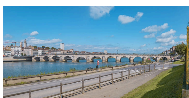
Vue d'ensemble du pont, d'aval et depuis la rive gauche.
