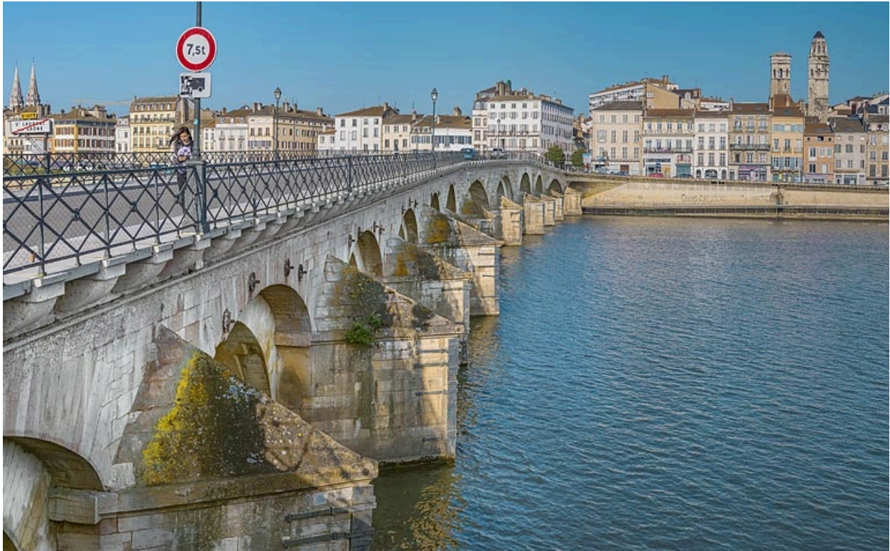
Les avant-becs du pont Saint-Laurent.
