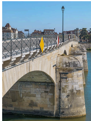
Détail des arrière-beccs du pont. Phot. Thierry Kuntz IVR26_20217100567NUC4A
