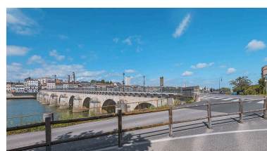
Vue d'ensemble du pont, d'aval et depuis la rive gauche. Phot. Thierry Kuntz IVR26_20217100560NUC4A
