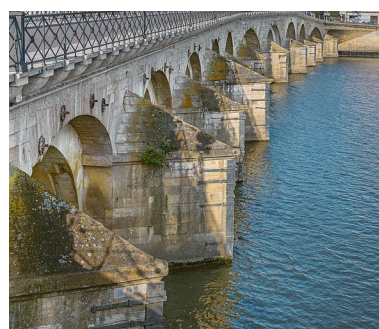
Les avant-becs du pont Saint-Laurent. Phot. Thierry Kuntz IVR26_20217100556NUC4A
