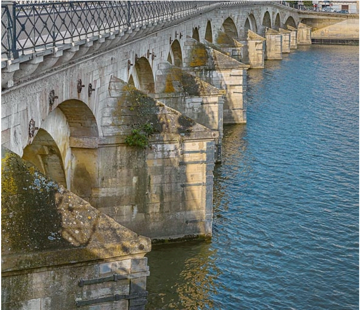
Les avant-becs du pont Saint-Laurent.
