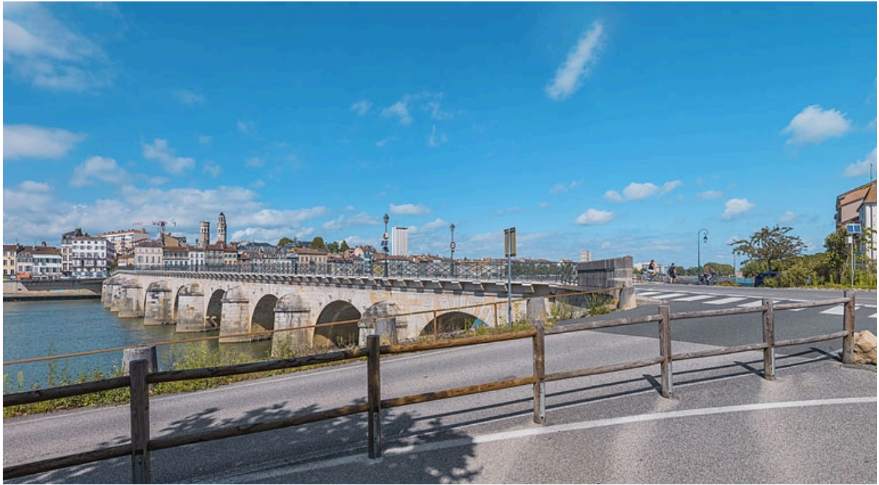
Vue d'ensemble du pont, d'aval et depuis la rive gauche.
