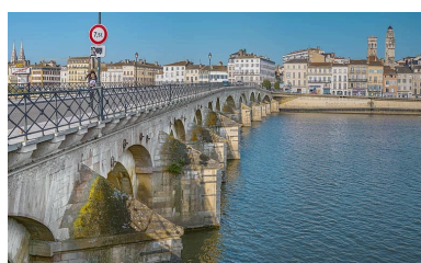
Les avant-becs du pont Saint-Laurent. Phot. Thierry Kuntz IVR26_20217100555NUC4A
