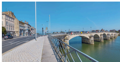
Le pont Saint-Laurent, vu d'aval, rive droite. Phot. Thierry Kuntz IVR26_20217100565NUC4A
