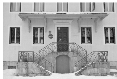
Escalier extérieur de l'atelier de fabrication. Phot. Laurent Poupard
