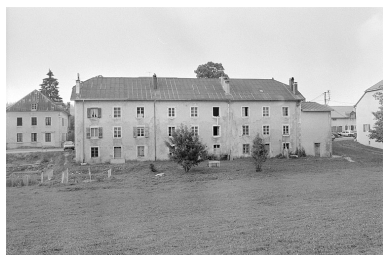
Façade postérieure du logement d'ouvriers. Phot. Jérôme Mongreville IVR43_19923900807X
