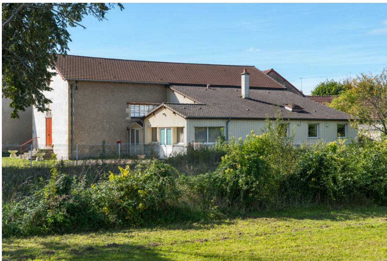
Façade latérale droite, de trois quarts gauche.
