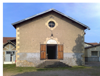
[Façade antérieure avant restauration]. S.d. [entre 2006 et 2014]. Autr. Jean-Paul Bruyère IVR26_20255800041NUC1A
