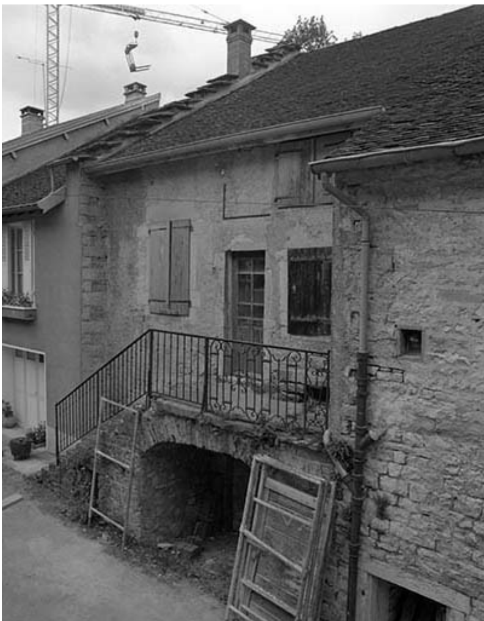
Façade antérieure vue de trois quarts en 1981.
