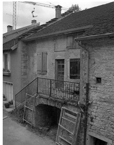
Façade antérieure vue de trois quarts en 1981. Phot. Yves Sancey IVR43_19813900140X
