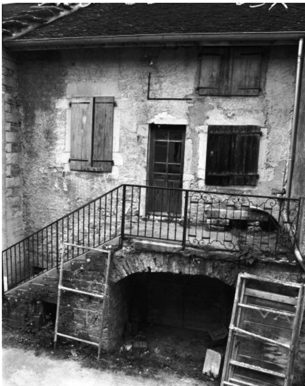
Façade antérieure vue de face en 1981.
