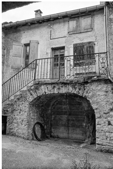
Façade antérieure en 1974. Phot. F. Pernin IVR43_19743900053Z
