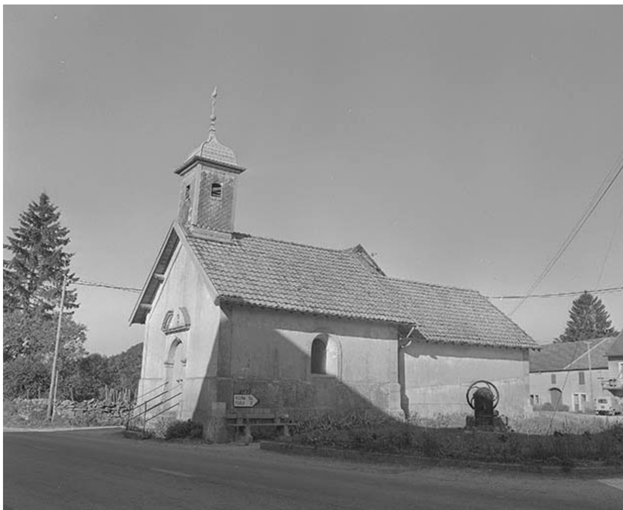
Extérieur : face latérale droite.
