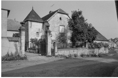
Vue d'ensemble. Phot. Dominique Dominguez IVR43_19807000353Z
