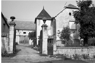
Vue des parties agricoles depuis le portail. Phot. Jean- Marie NEPASUTILISERBaverel IVR43_19807000354Z
