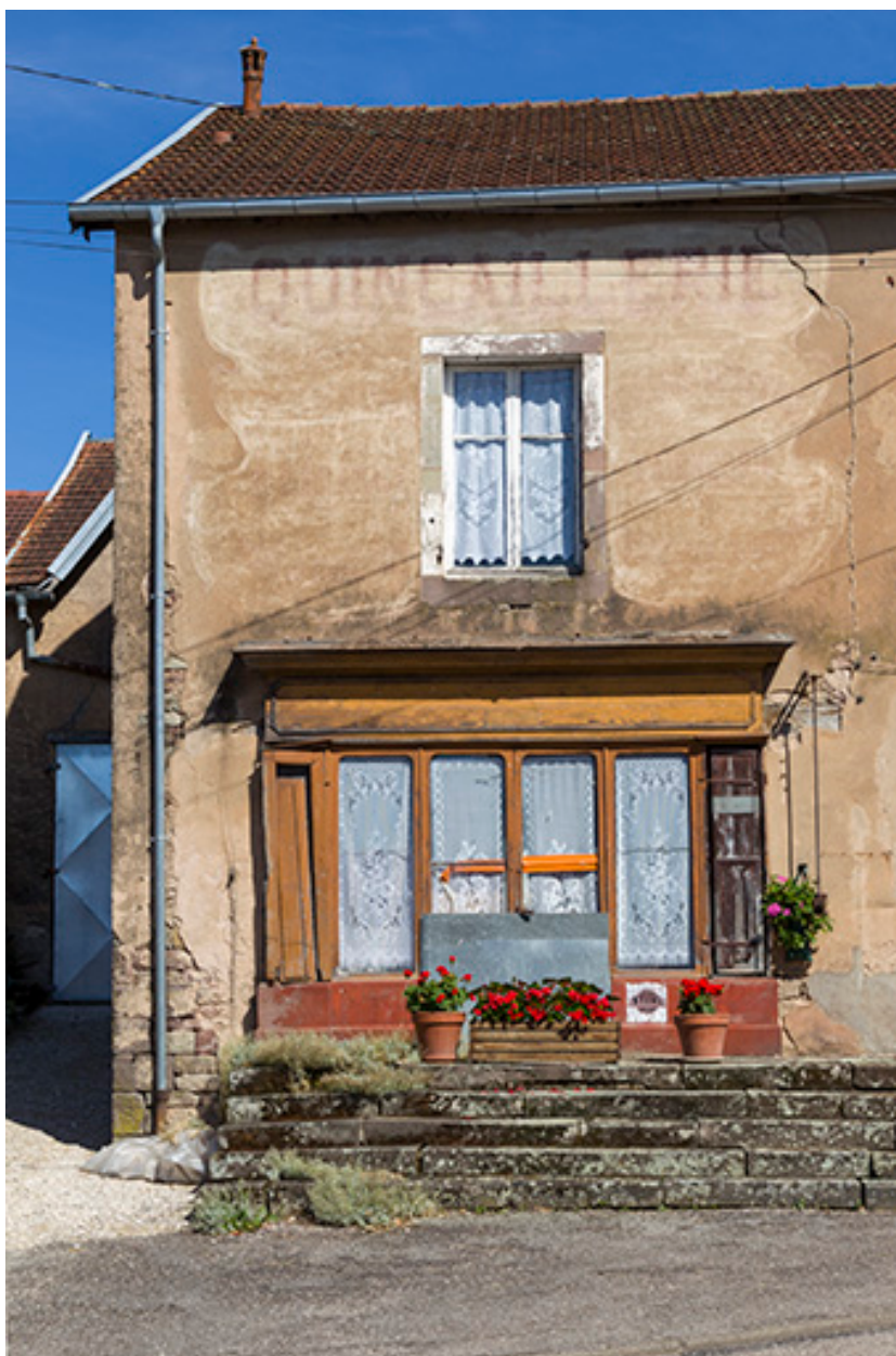
Ancienne boutique, rue de la Forge.
