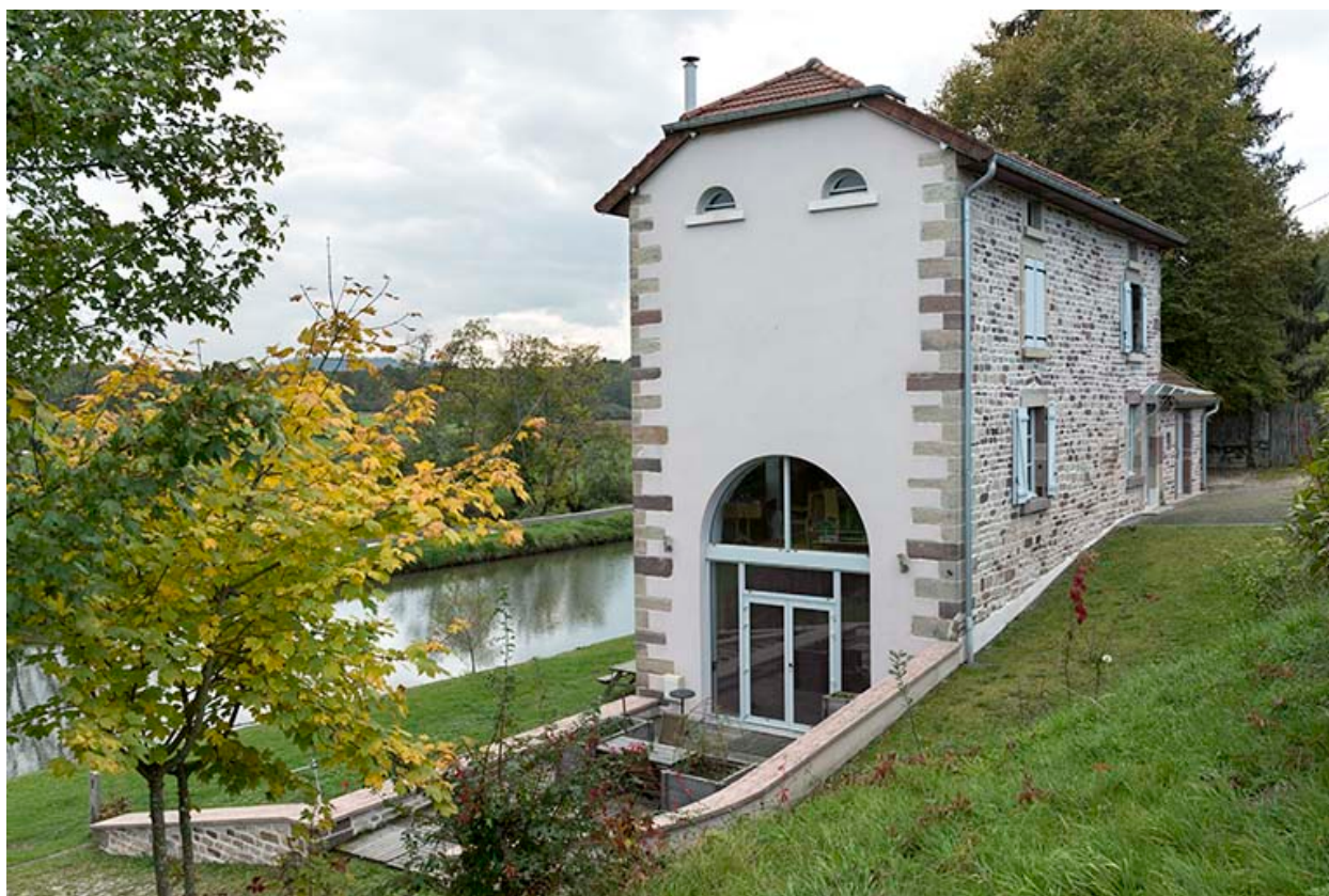
Maison située face au canal, vue latérale (3).
