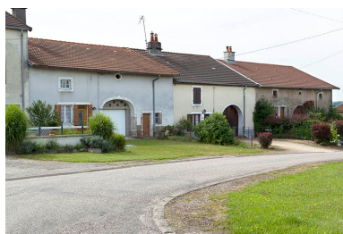
Alignement de fermes, rue de Pont-du-Bois. Phot. Sonia Dourlot IVR43_20157001150NUC2A
