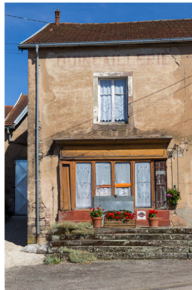
Ancienne boutique, rue de la Forge.
