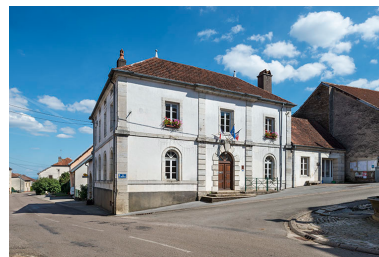
Vue depuis la Grande Rue. Phot. Jérôme Mongreville IVR43_20177001309NUC4A
