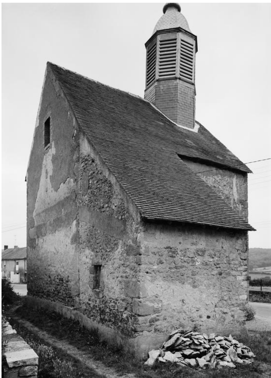
Mur postérieur et mur gauche.
