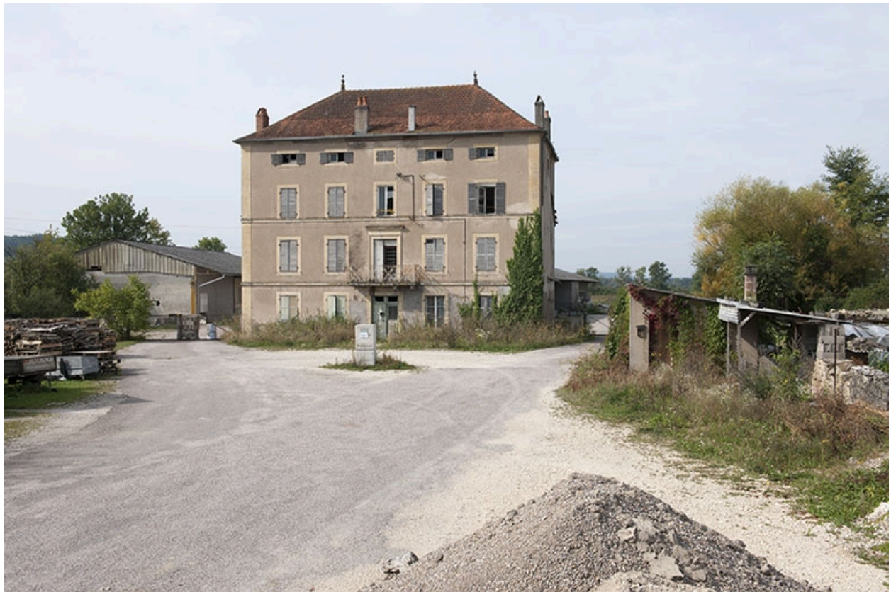
Vue générale depuis l'entrée.
