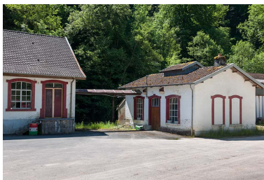
bâtiment de la forge. Phot. Jérôme Mongreville IVR43_20132500654NUC4A
