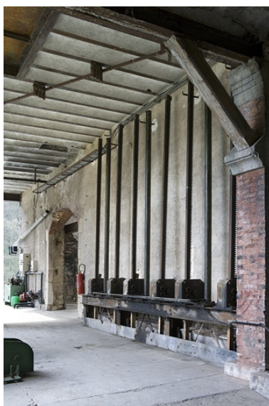
Bâtiment d'eau. Vue rapprochée du système Fontaine. Phot. Yves Sancey IVR43_20092500348NUC2A
