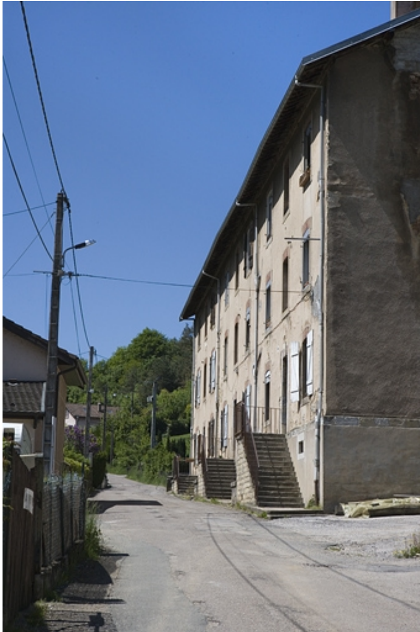
Logement d'ouvriers (rue du Tâtre). Façade antérieure.
