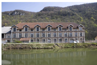
Façade antérieure de l'atelier de façonnage.
