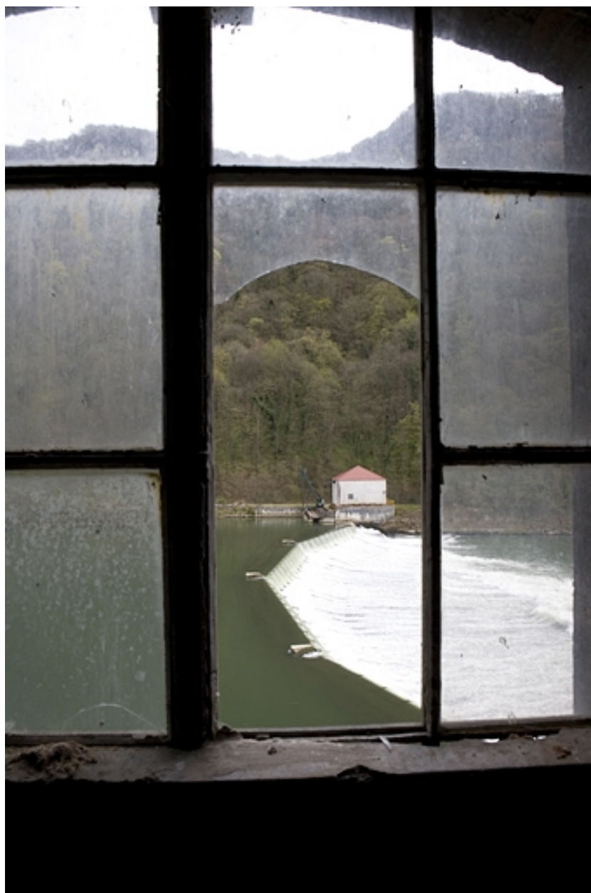
Vue du barrage depuis la rive droite.
