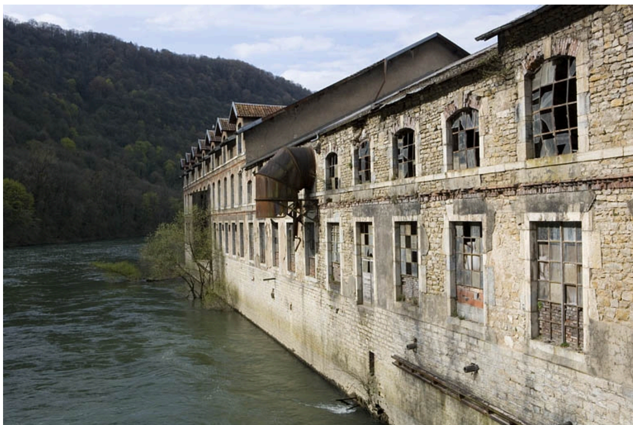
Ateliers de la machine à papier et façonnage. Façade postérieure.
