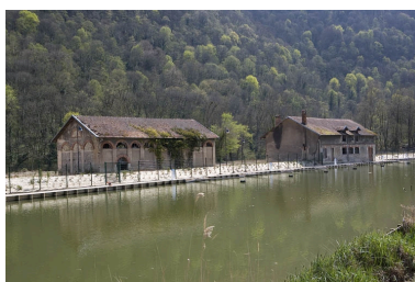
Vue de trois quarts gauche de l'atelier de réparation et de l'écurie.
