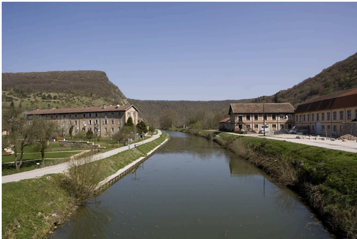
Logement d'ouvriers (10 à 16 rue des Ecoles), canal et usine de papeterie.
