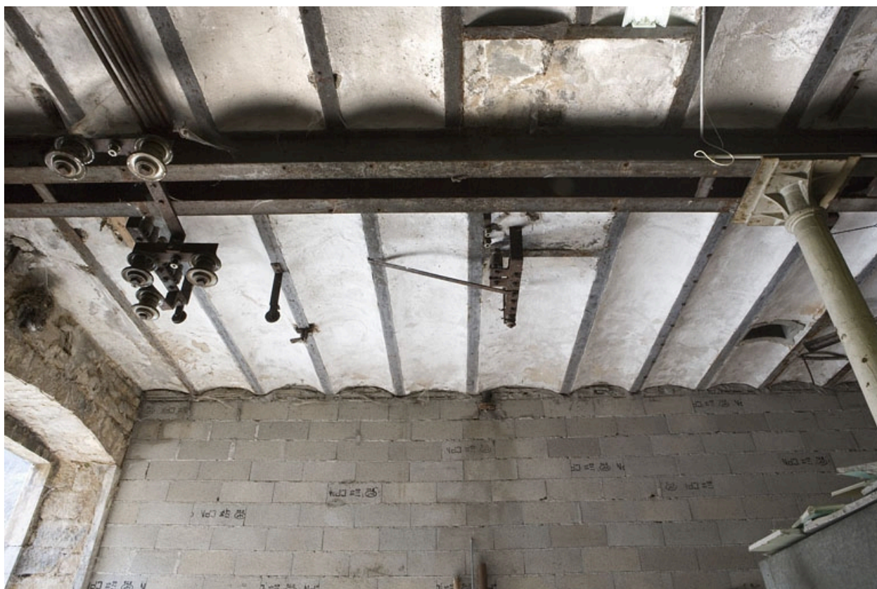
Bâtiment d'eau. Détail du plancher supérieur en entrevous en berceau segmentaire.
