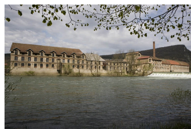
Vue d'ensemble depuis l'aval.
