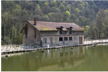
Vue de trois quarts arrière de l'atelier de réparation. Phot. Yves Sancey IVR43_20092500384NUC2A
