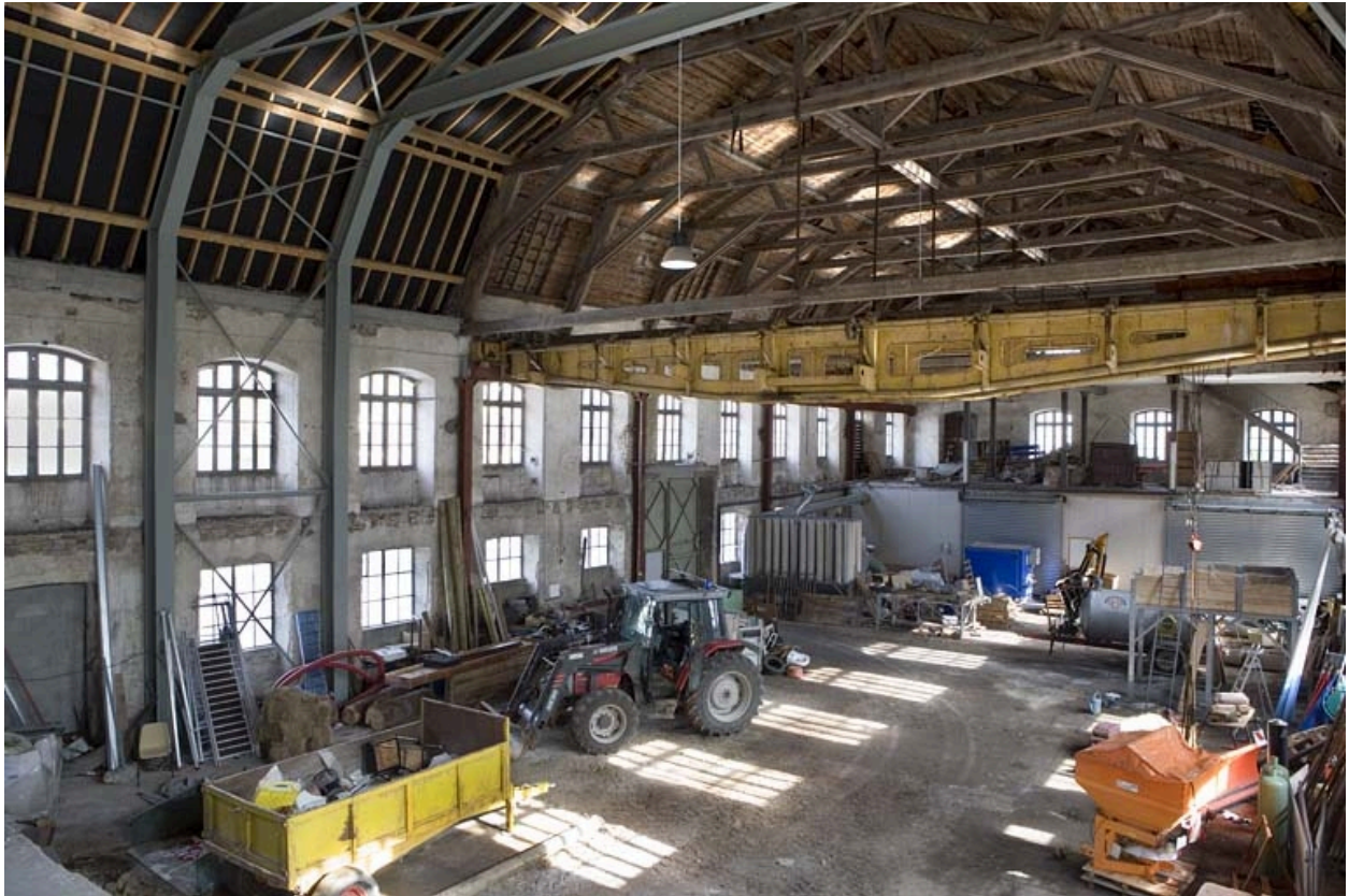
Atelier de préparation de la pâte. Vue intérieure depuis le premier étage.
