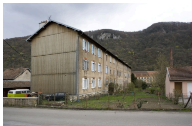
Logement d'ouvriers (10 à 16 rue des Ecoles). Façade sud-ouest. Phot. Yves Sancey IVR43_20092500388NUC2A
