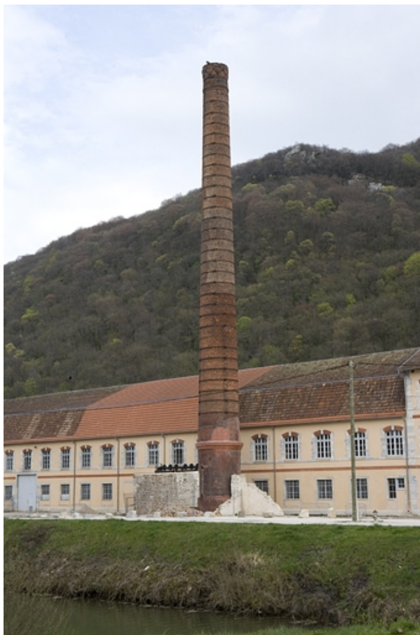
Vue de la cheminée, depuis le chemin de halage.
