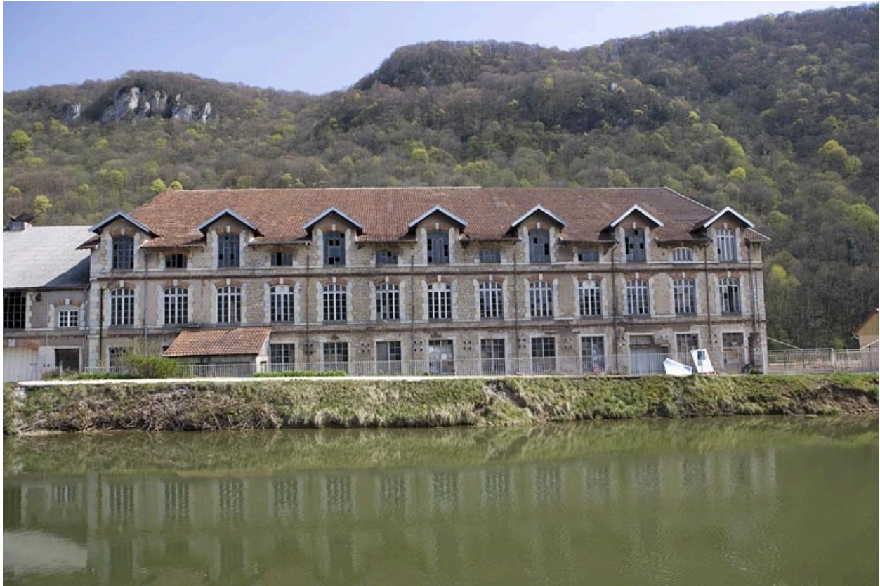
Façade antérieure de l'atelier de façonnage.
