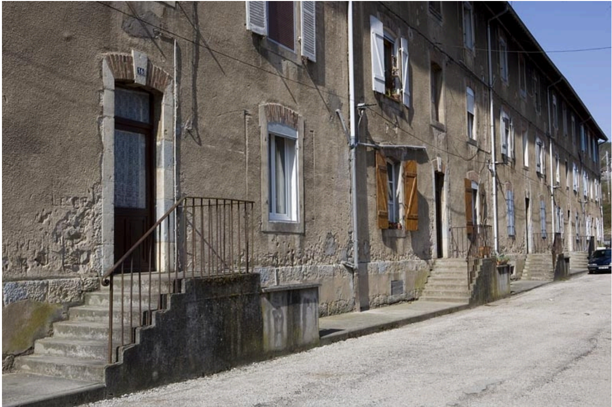
Logement d'ouvriers (10 à 16 rue des Ecoles). Détail des entrées sur la façade nord.
