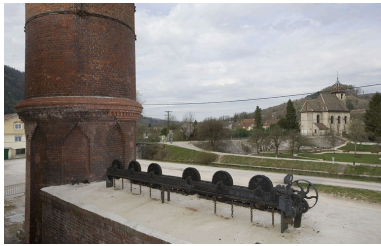
Système de levage des portes (?) de la chaudière. Phot. Yves Sancey IVR43_20092500341NUC2A
