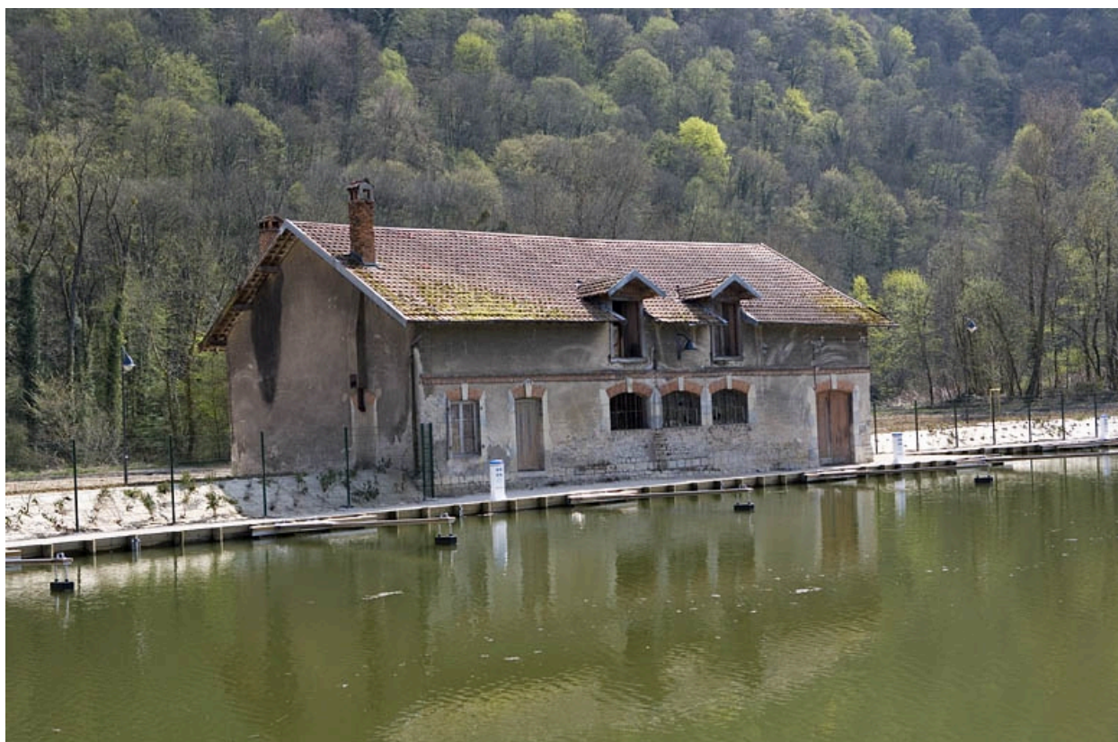
Vue de trois quarts arrière de l'atelier de réparation.
