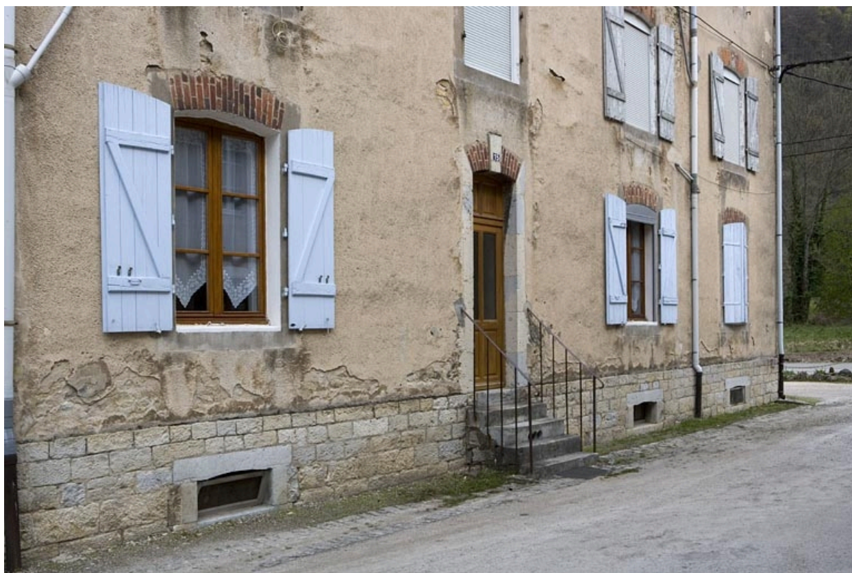
Cité ouvrière (rue des Ecoles). Détail d'une entrée.
