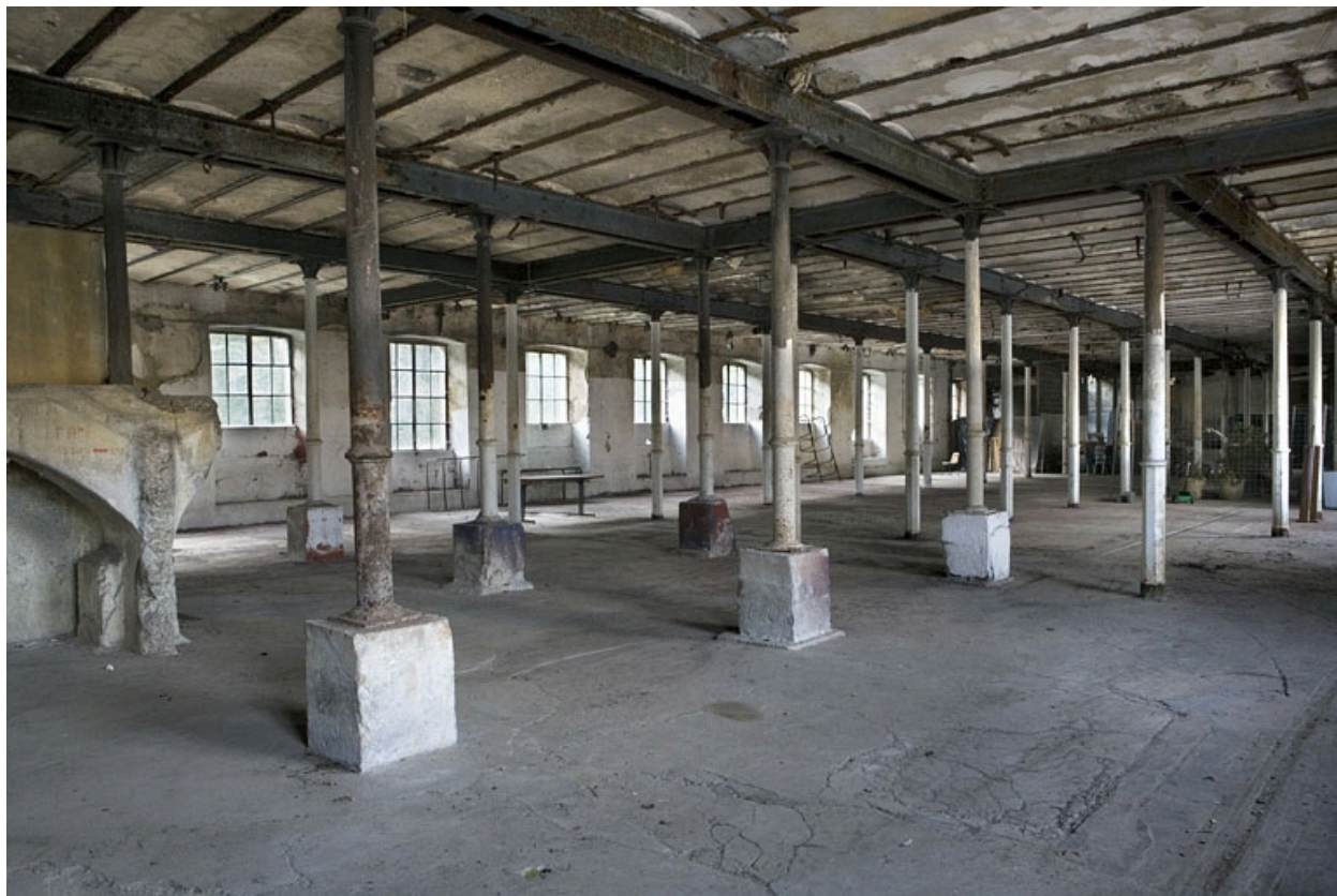
Atelier de préparation de la pâte. Vue intérieure du rez-de-chaussée.
