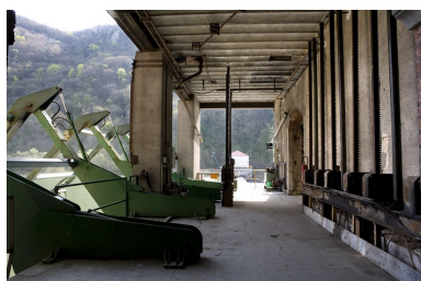
Bâtiment d'eau. Système d'admission et de régulation (système Fontaine) et dégrilleur. Phot. Yves Sancey IVR43_20092500352NUC2A
