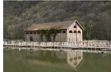
Vue de trois quarts droite de l'atelier de réparation. Phot. Yves Sancey IVR43_20092500387NUC2A
