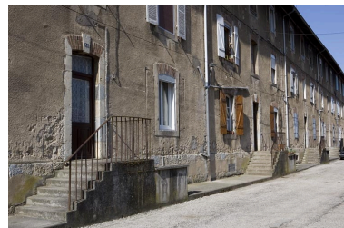
Logement d'ouvriers (10 à 16 rue des Ecoles). Détail des entrées sur la façade nord. Phot. Yves Sancey IVR43_20092500391NUC2A
