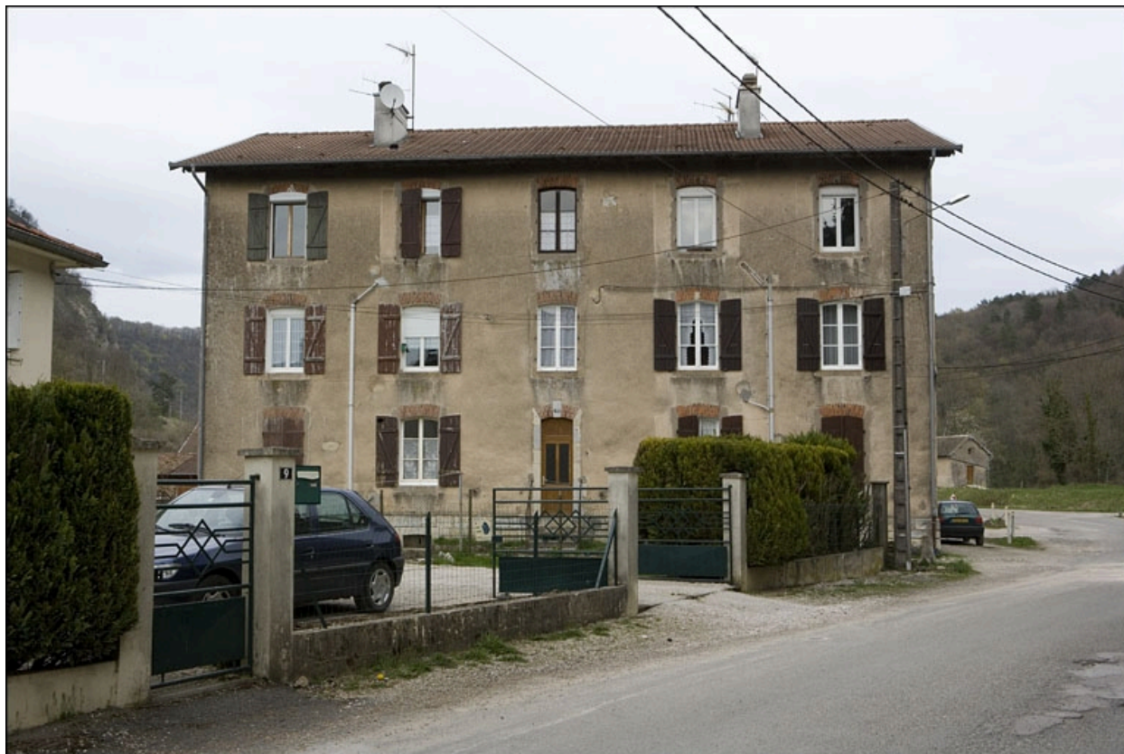
Cité ouvrière (rue des Ecoles). Façade sud.
