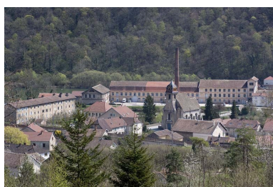
Vue générale rapprochée. Phot. Yves Sancey IVR43_20092500333NUC2A
