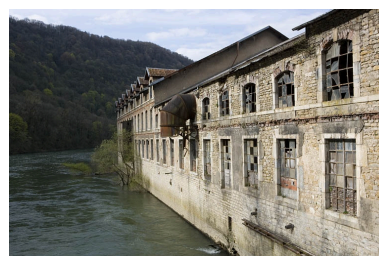
Ateliers de la machine à papier et façonnage. Façade postérieure. Phot. Yves Sancey IVR43_20092500323NUC2A
