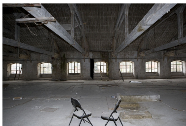
Atelier de préparation de la pâte. Vue intérieure du second étage. Phot. Yves Sancey IVR43_20092500365NUC2A
