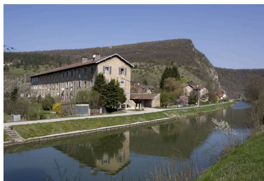
Logement d'ouvriers (10 à 16 rue des Ecoles). Vue de trois quarts. Phot. Yves Sancey IVR43_20092500392NUC2A
