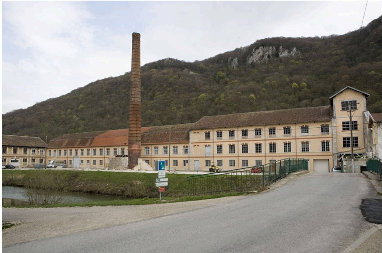
Vue de trois quarts gauche des ateliers de préparation de la pâte.
