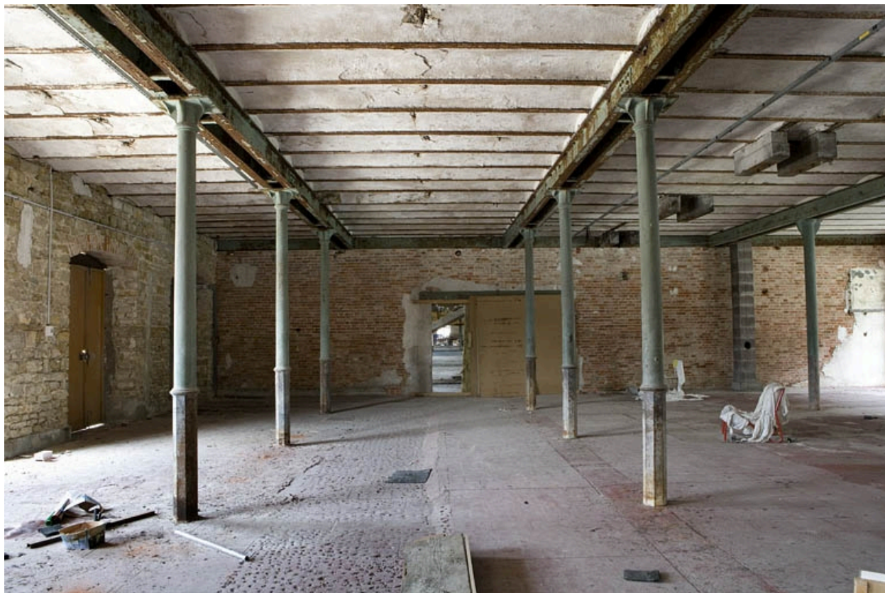
Atelier de préparation de la pâte. Partie nord (premier étage).
