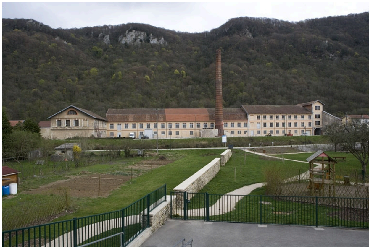
Façades ouest des ateliers.
