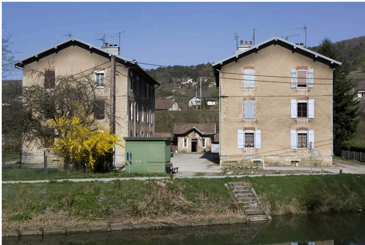
Cité ouvrière (rue des Ecoles). Pignons est.
