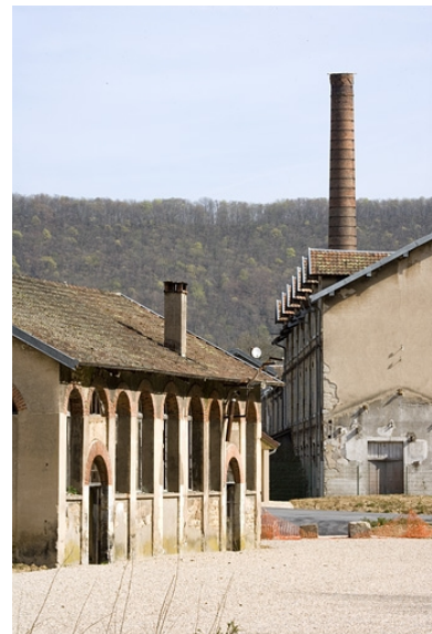
Façade de l'atelier de réparation et cheminée, depuis l'aire des déchets. Phot. Yves Sancey IVR43_20092500342NUC2A
