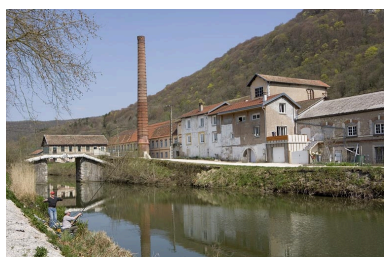
Vue de trois quarts droite de la papeterie, depuis le chemin de halage.
