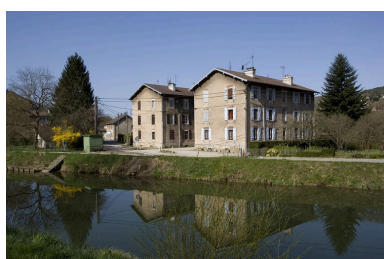
Cité ouvrière (rue des Ecoles). Vue depuis le nord. Phot. Yves Sancey IVR43_20092500397NUC2A
