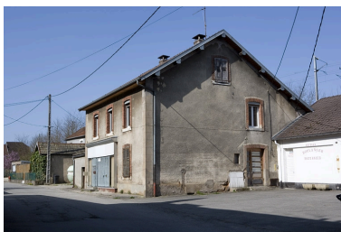
La coopérative "La Fraternelle". Vue de trois quarts droite. Phot. Yves Sancey IVR43_20092500400NUC2A
