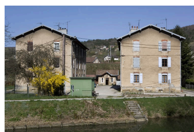
Cité ouvrière (rue des Ecoles). Pignons est. Phot. Yves Sancey IVR43_20092500396NUC2A
