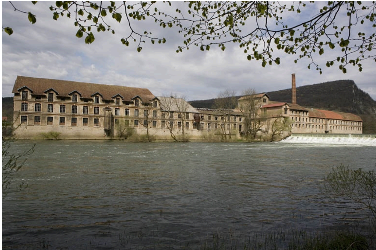
Vue d'ensemble depuis l'aval.
