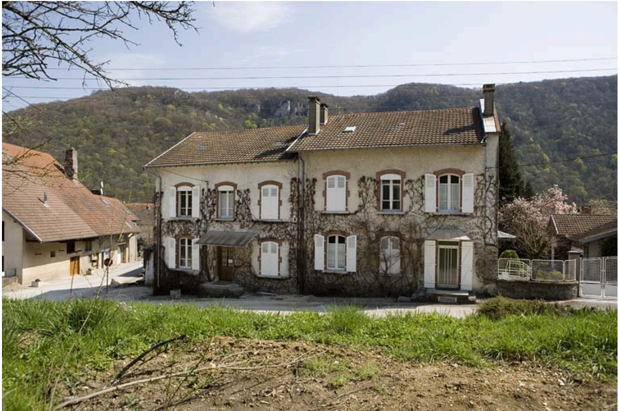
Logement patronal. Vue de la façade arrière.
