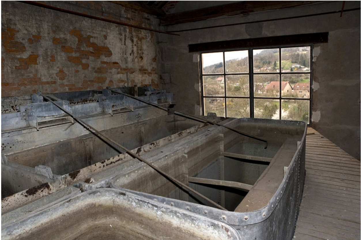
Atelier de préparation de la pâte. Cuves de stockage et de distribution de l'eau.
