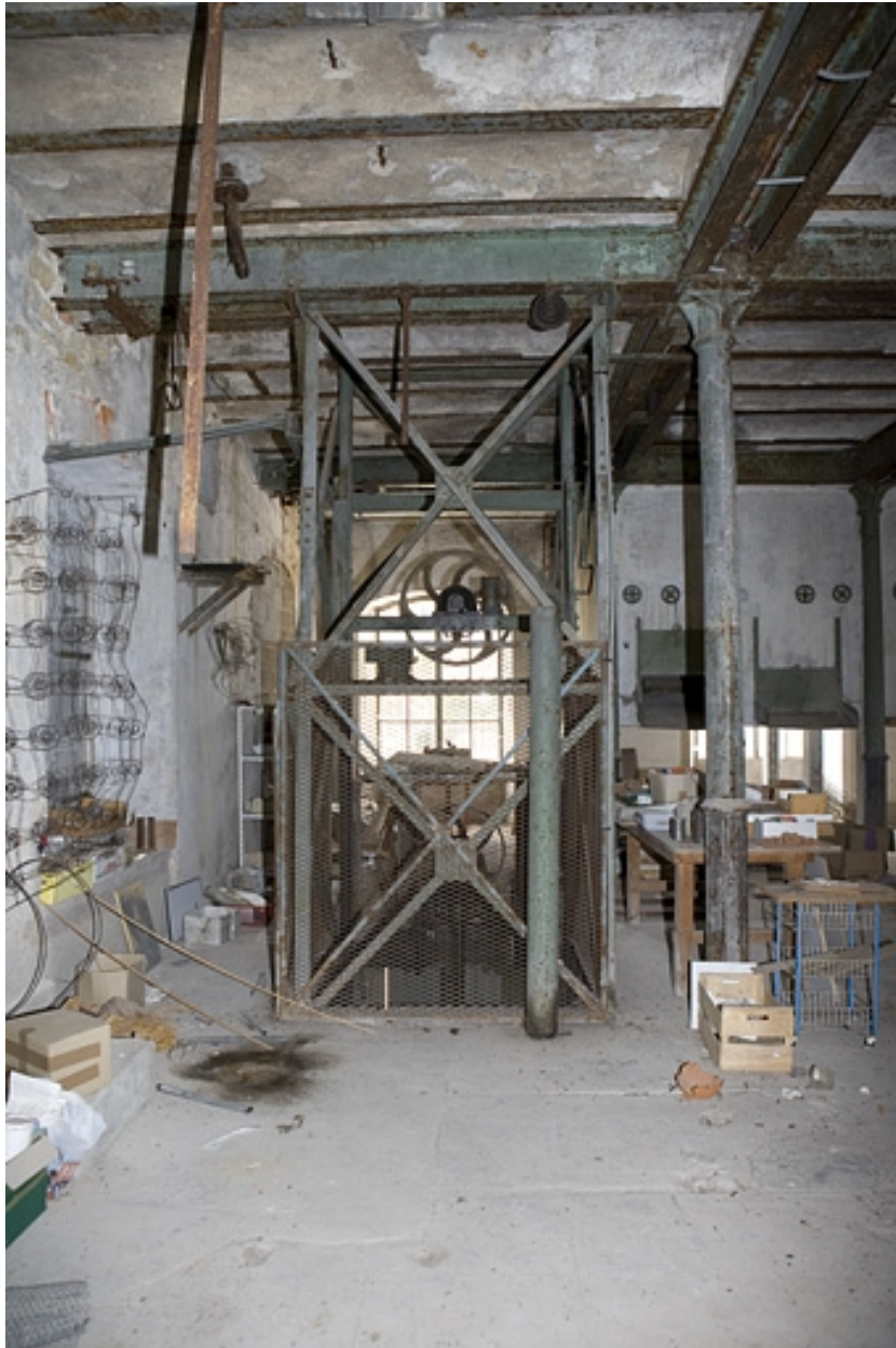
Atelier de préparation de la pâte. Monte-charge à vis, au premier étage.
