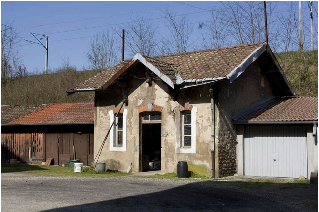
Cité ouvrière (rue des Ecoles). Vue de trois quarts droit de la resserre.
