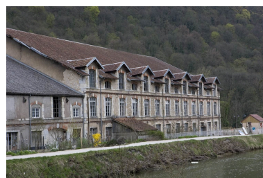
Vue de trois quarts gauche de l'atelier de façonnage.
