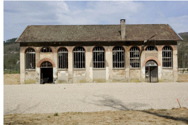
Façade est de l'atelier de réparation. Phot. Yves Sancey IVR43_20092500376NUC2A
