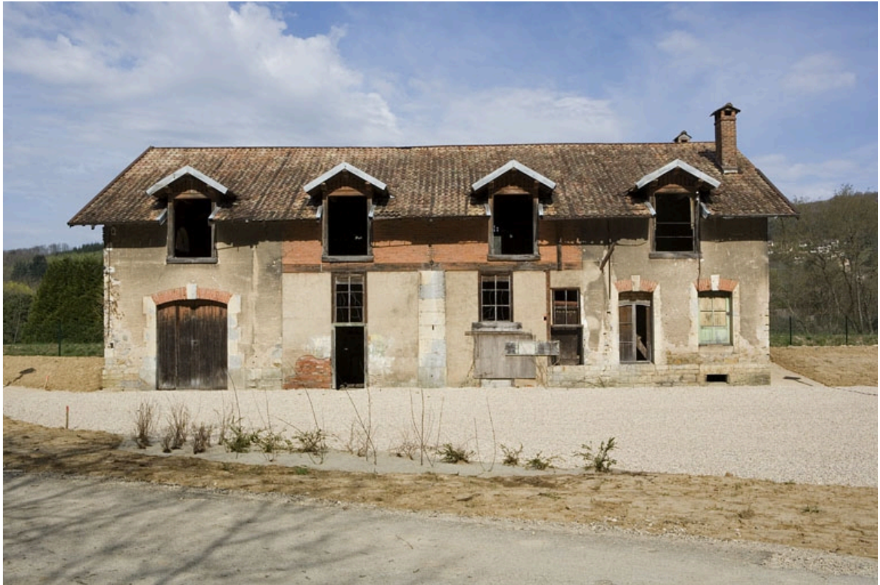
Façade est de l'écurie.
