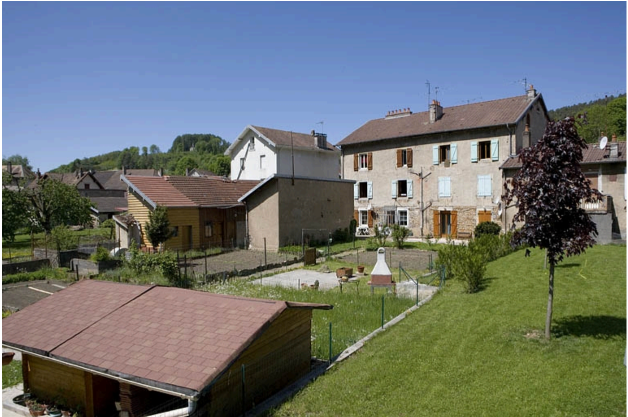
Ecole ménagère et logement d'ouvriers. Façade postérieure.
