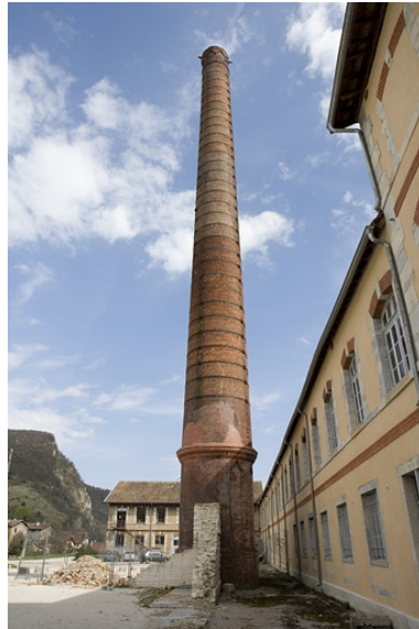
Vue de la cheminée, depuis la cour. Phot. Yves Sancey IVR43_20092500344NUC2A
