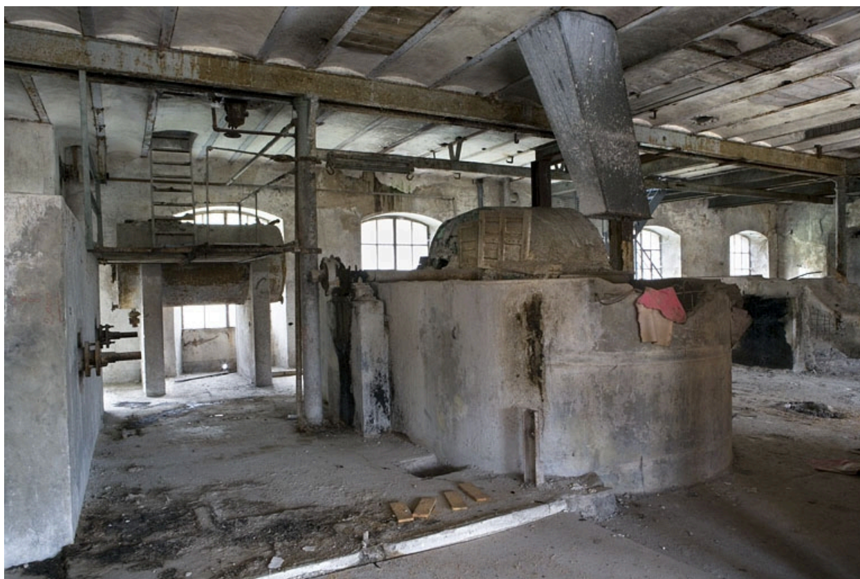
Atelier de préparation de la pâte. Pile raffineuse (premier étage).
