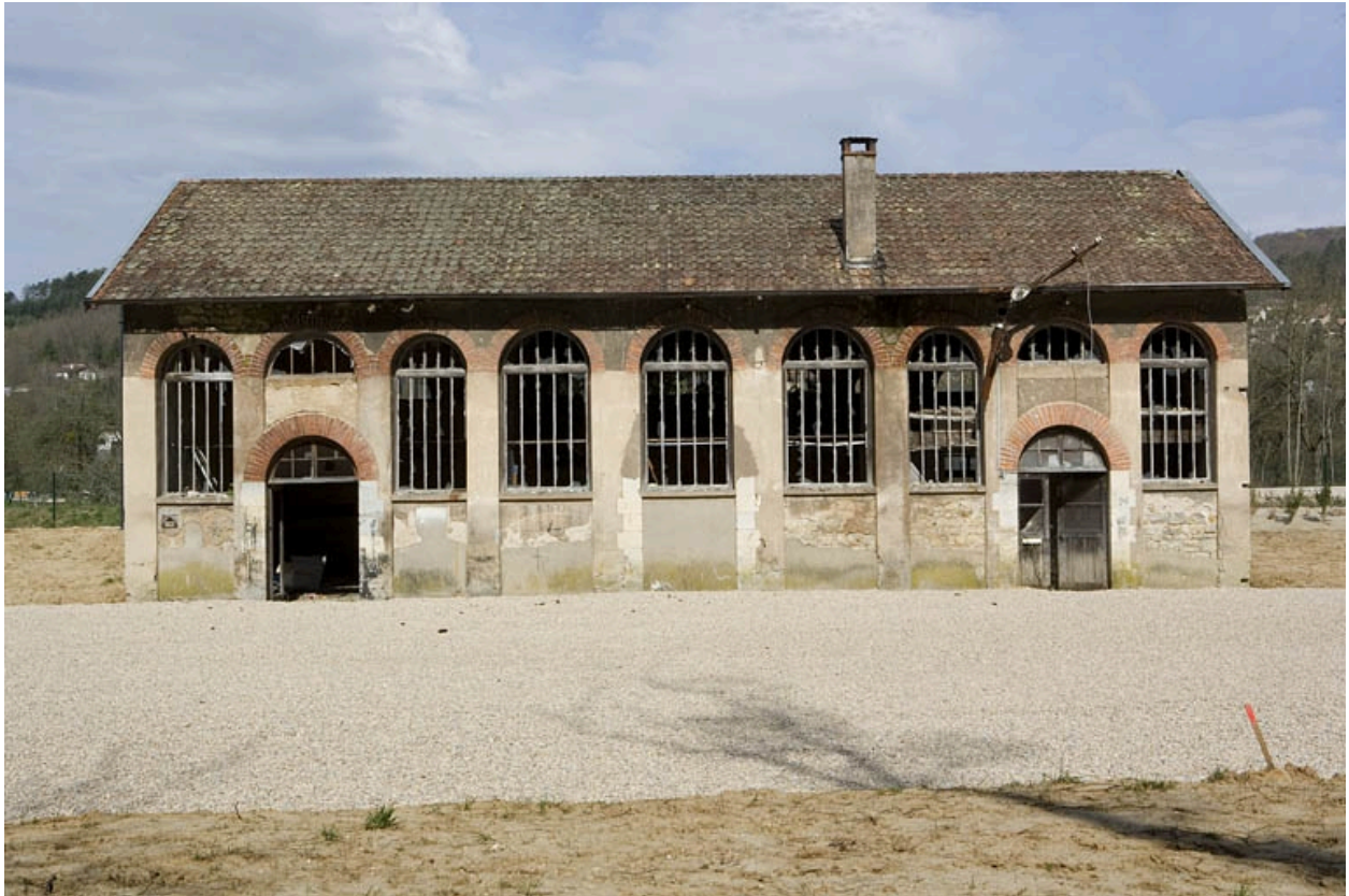
Façade est de l'atelier de réparation.
