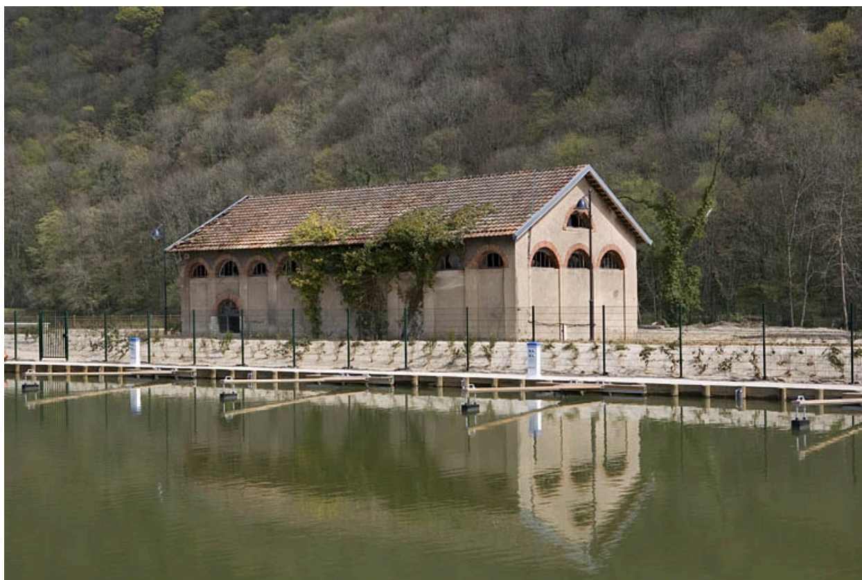
Vue de trois quarts droite de l'atelier de réparation.
