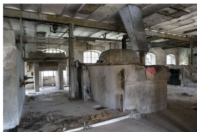
Atelier de préparation de la pâte. Pile raffineuse (premier étage). Phot. Yves Sancey IVR43_20092500373NUC2A
