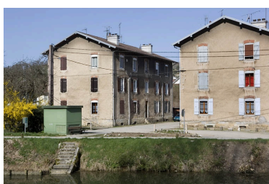
Cité ouvrière (rue des Ecoles). Vue de trois quarts. Phot. Yves Sancey IVR43_20092500398NUC2A
