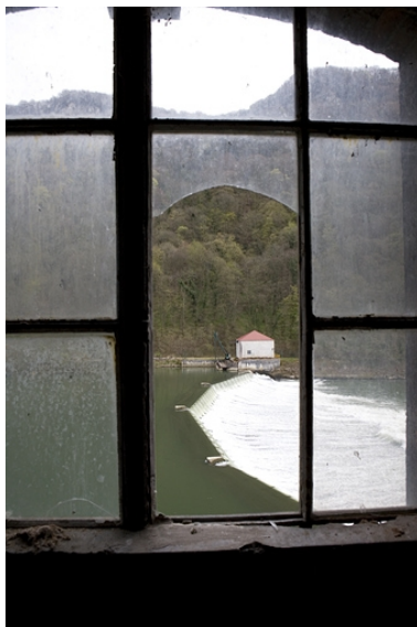
Vue du barrage depuis la rive droite. Phot. Yves Sancey IVR43_20092500346NUC2A
