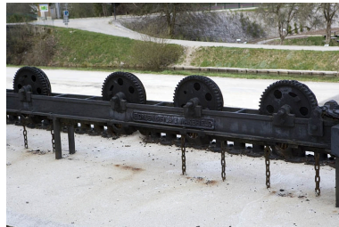
Détail des engrenages du système de levage des portes (?). Phot. Yves Sancey IVR43_20092500340NUC2A
