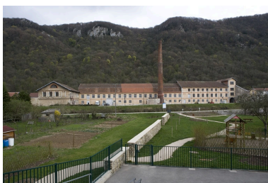
Façades ouest des ateliers.
