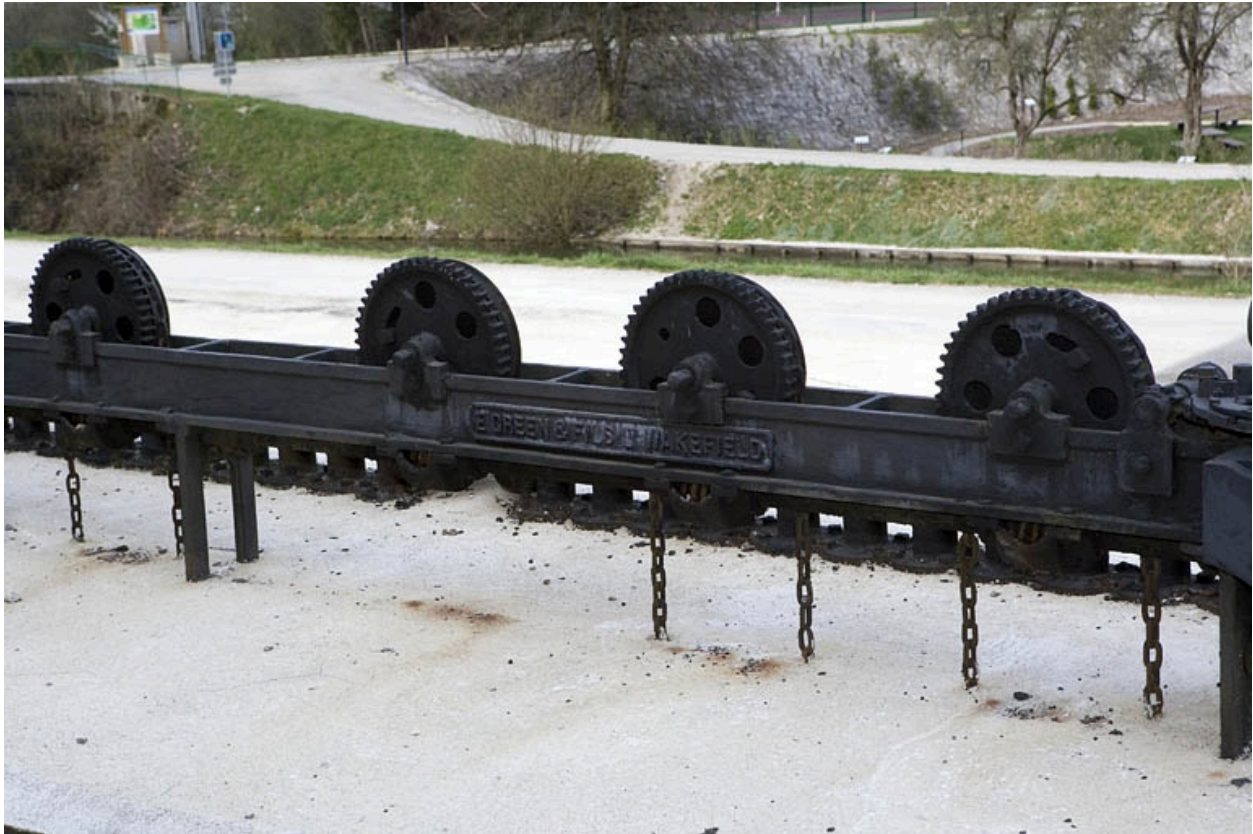
Détail des engrenages du système de levage des portes (?).
