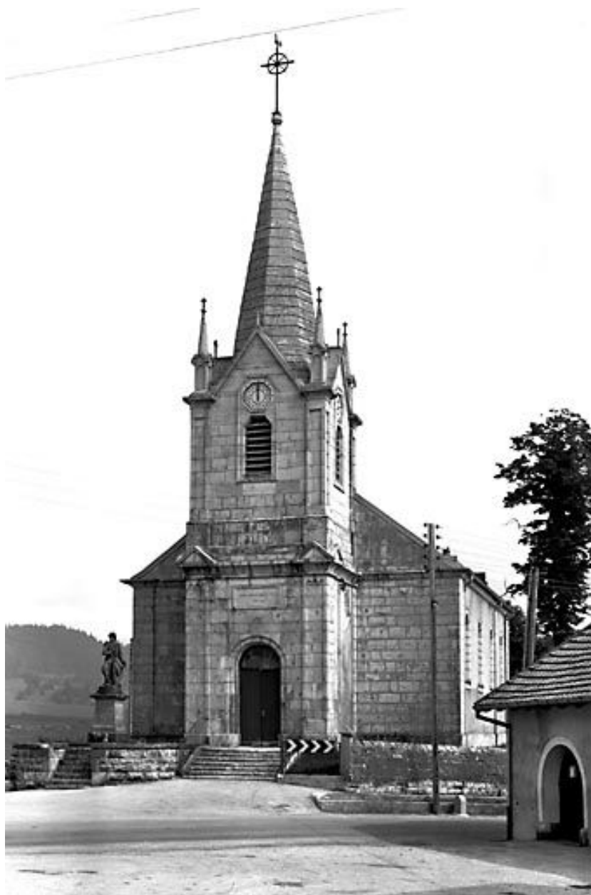
Façades antérieure et latérale droite.
