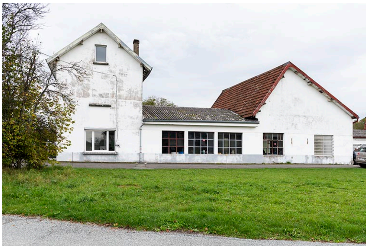
Bâtiments nord : façade latérale droite.
