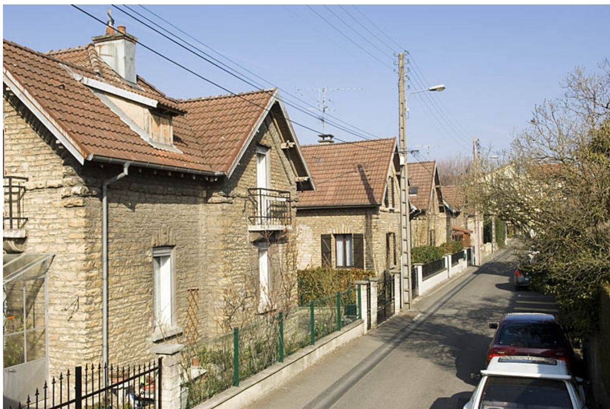
Façades antérieures sur la rue des Fleurs.
