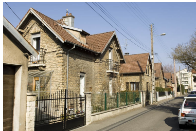
Maisons ouvrières (côté impair). Phot. Marc Loukachine IVR43_20122500267NUC2A
