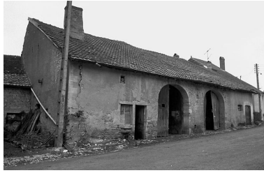
Vue de trois quarts gauche. Phot. Bernard Lardière IVR43_19797000091Z
