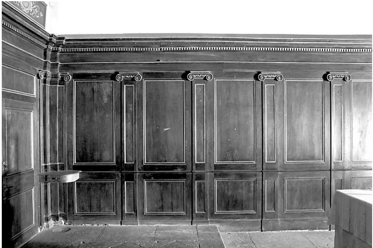
Détail des boiseries du chœur.
