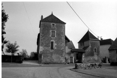
Vue d'ensemble depuis la rue d'Avrigny. Phot. Bernard Lardière IVR43_19797000113Z
