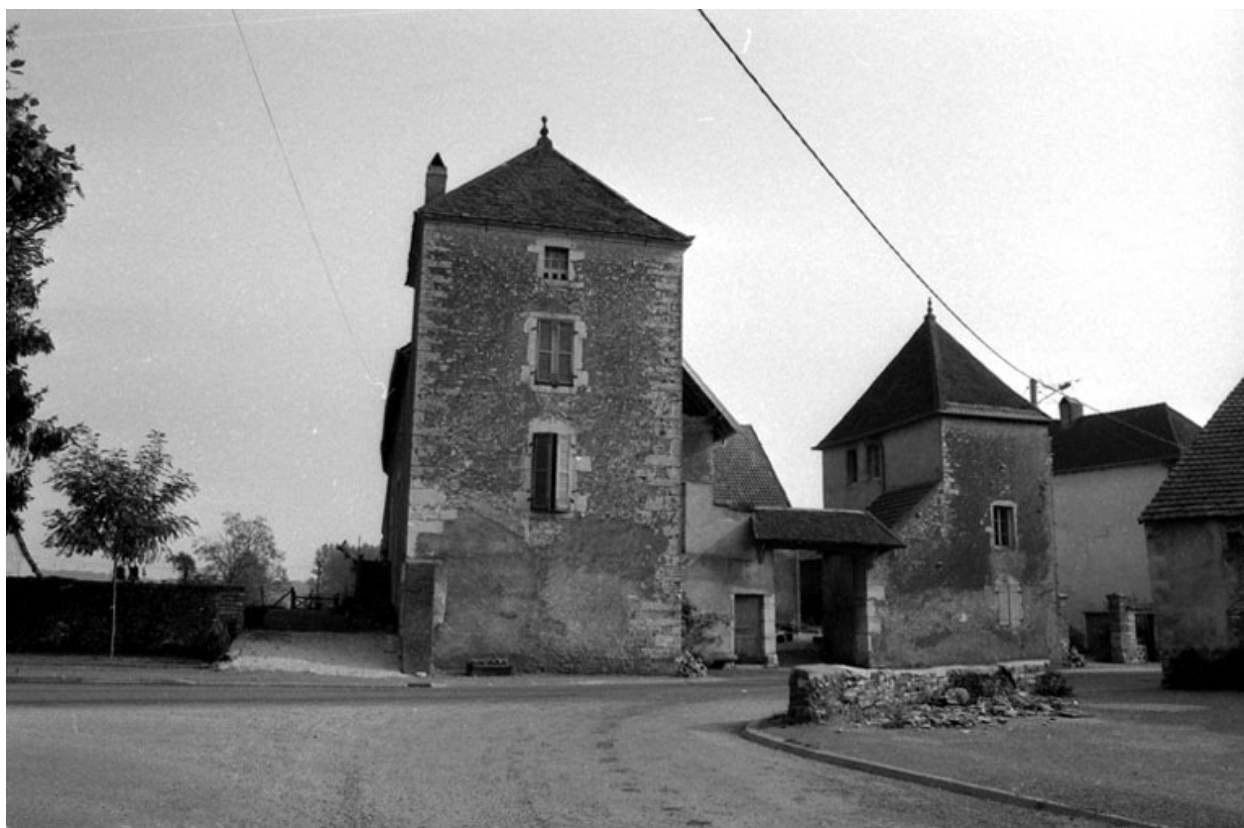
Vue d'ensemble depuis la rue d'Avrigny.
