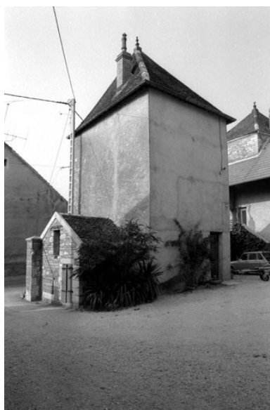
Tour vue depuis la cour. Phot. Bernard Lardière IVR43_19797000119Z
