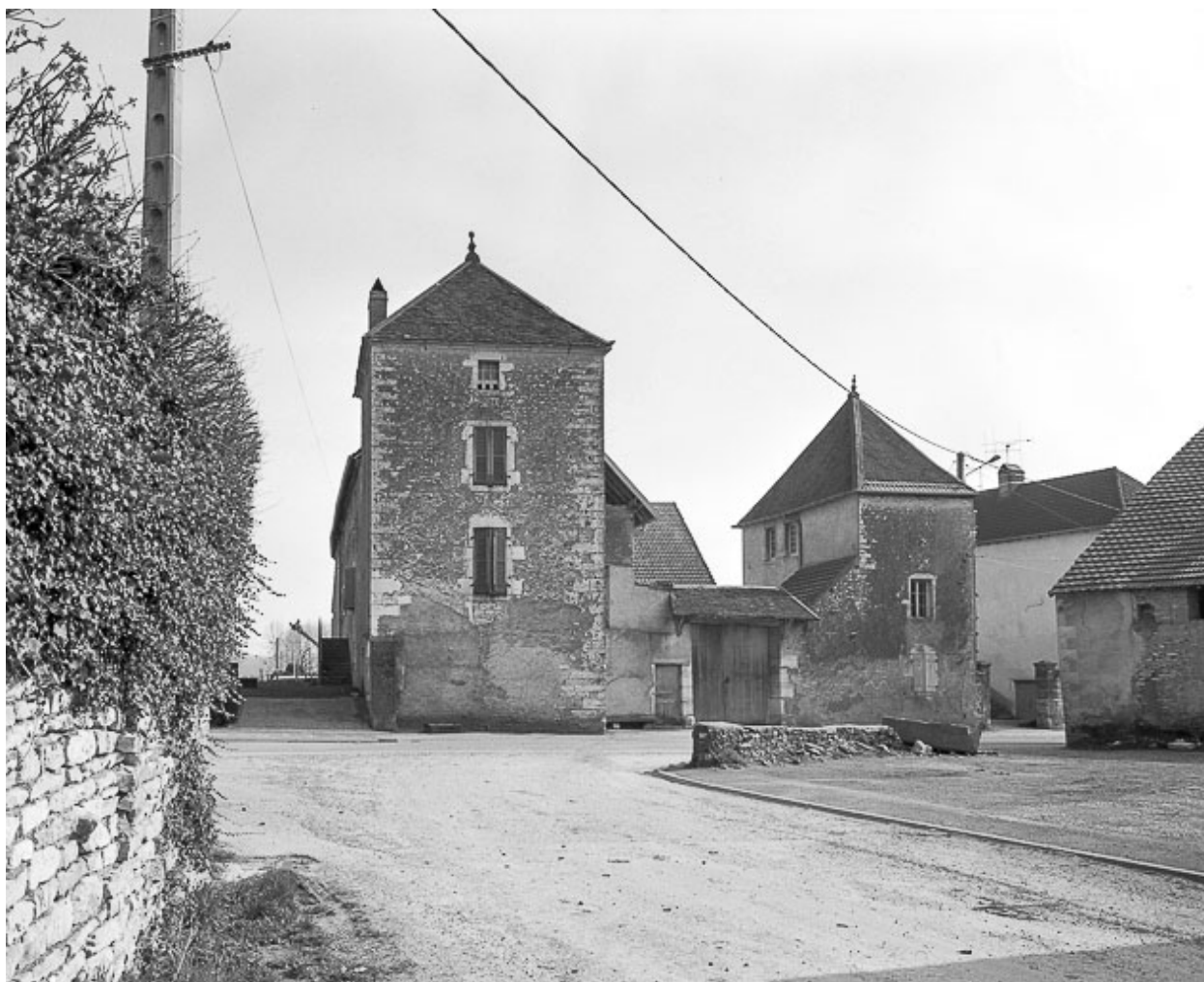
Vue d'ensemble depuis la rue d'Avrigny.
