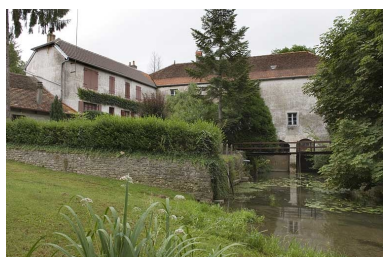
Vue d'ensemble depuis le bief, en aval. Phot. Jérôme Mongreville IVR43_20097000674NUC2A
