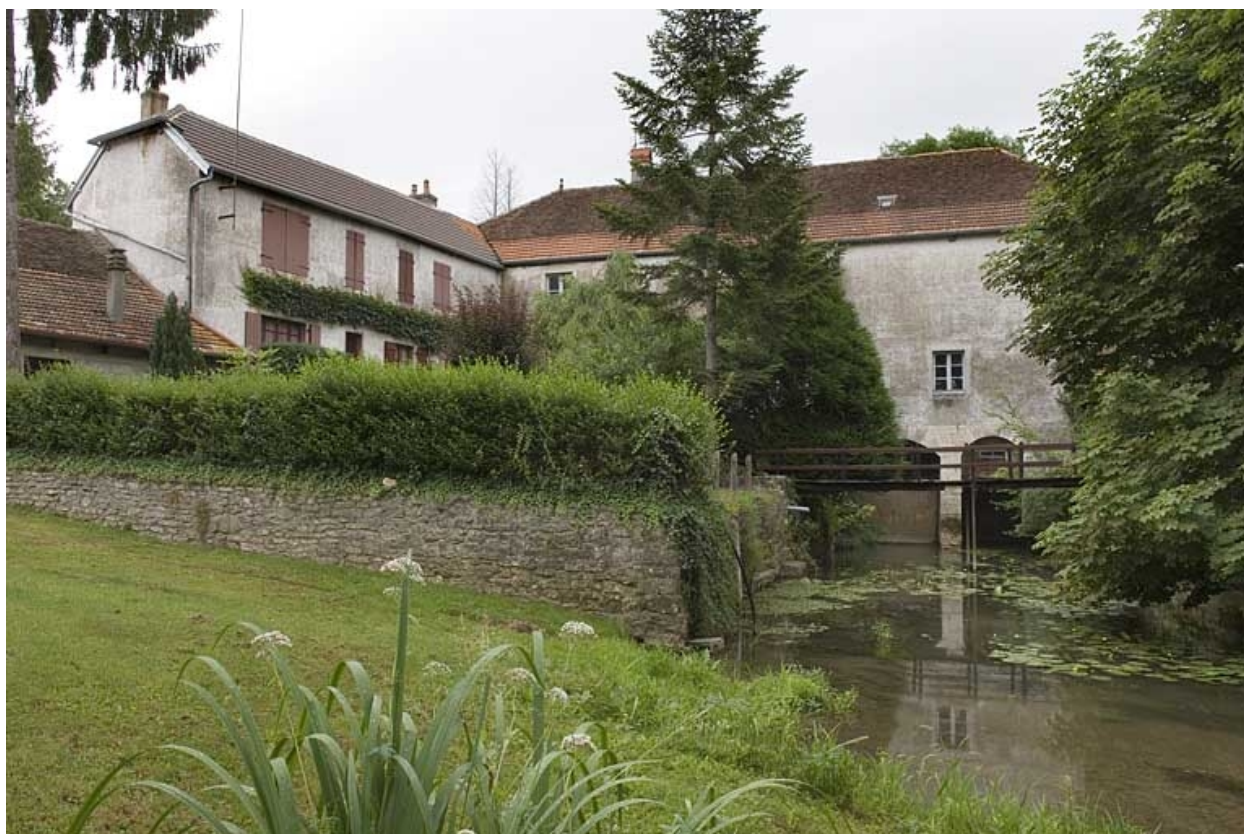
Vue d'ensemble depuis le bief, en aval.
