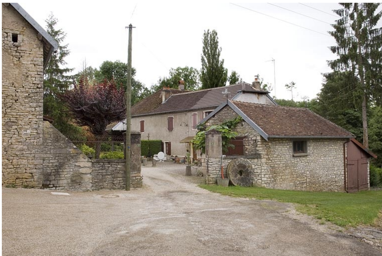
Vue d'ensemble depuis la rue.
