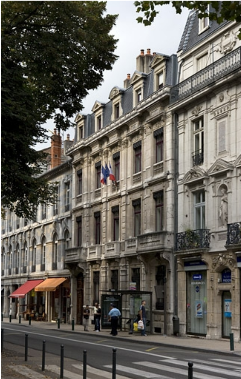
Vue d'ensemble depuis la rue, de trois quarts droit : vue rapprochée.
