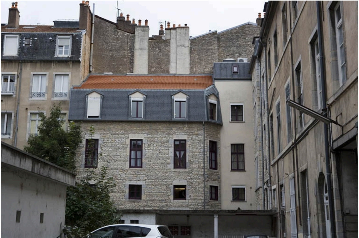
Façade latérale droite sur cour.
