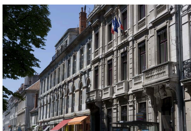
Détail de la façade sur rue, de trois quarts droit.
