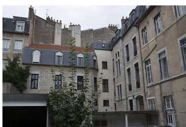
Vue d'ensemble de la façade postérieure du logis principal, et aile droite sur cour.
