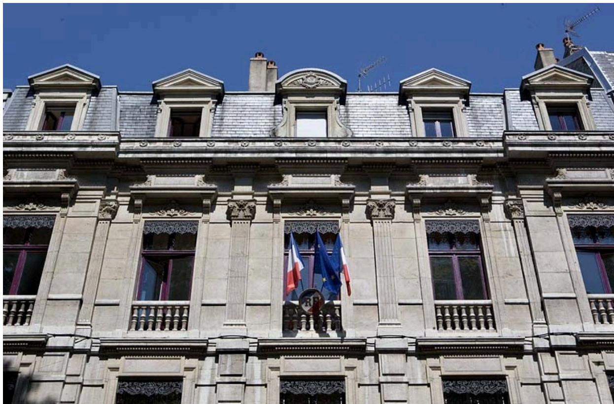
Détail du deuxième étage et de l'étage de comble : façade sur rue, de face.
