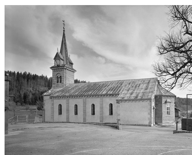
Façade latérale droite. Phot. Jérôme Mongreville IVR43_20003900594V
