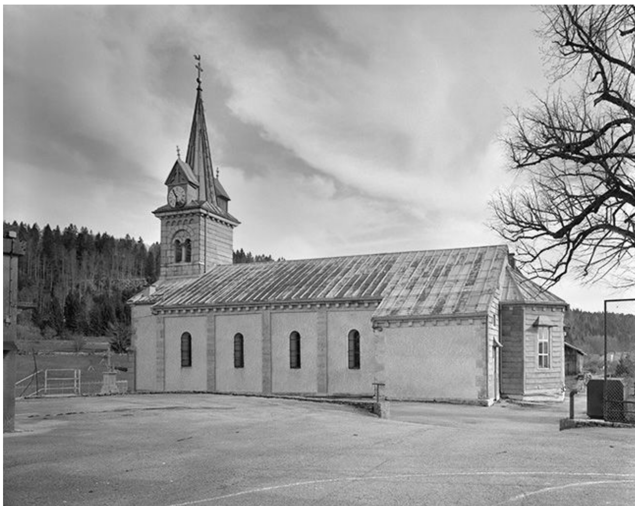
Façade latérale droite.
