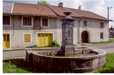
Vue de trois quarts du bassin. Phot. Yves Sancey IVR43_19993900191ZA
