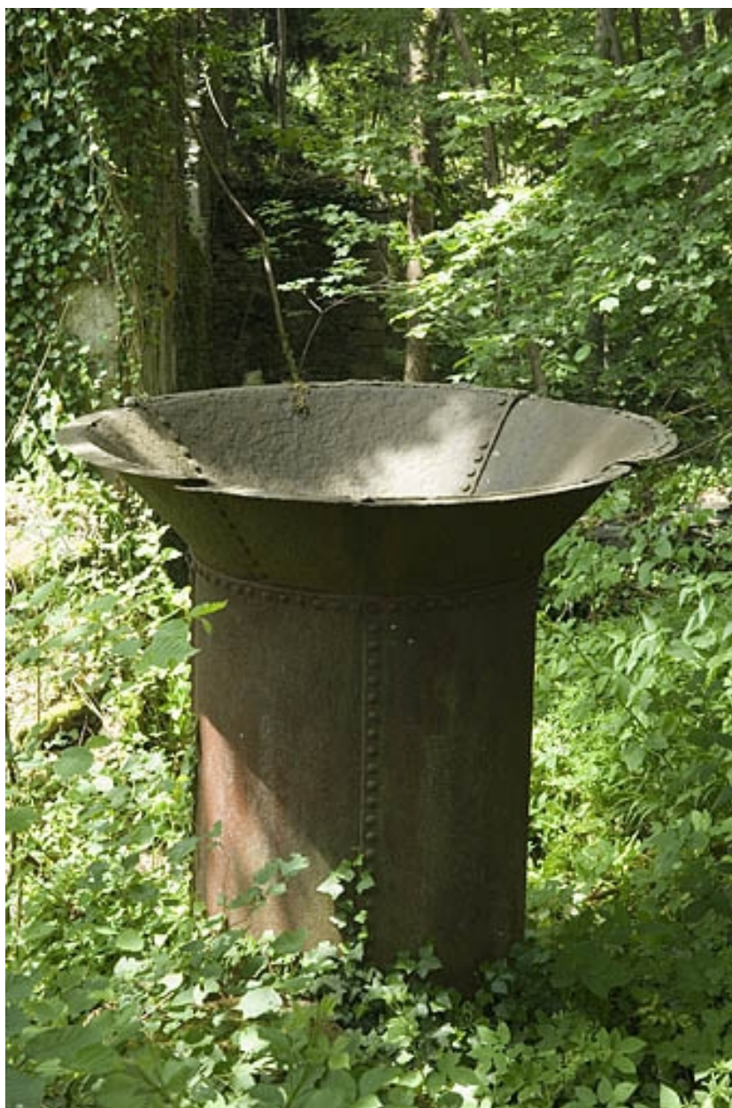
Couronnement métallique d'une cheminée en tôle.
