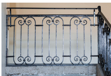
Grand escalier : garde-corps du dernier palier.
