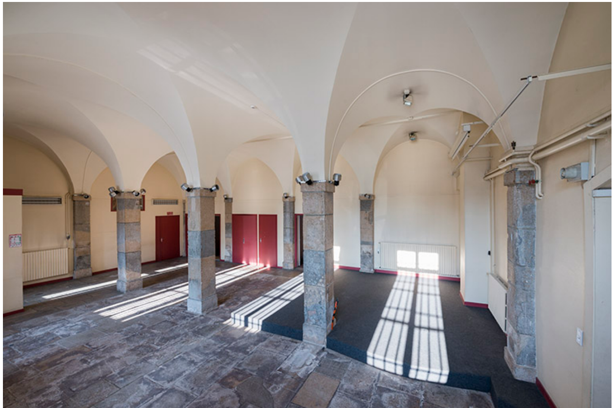
Rez-de-chaussée, partie gauche : pièce voûtée.
