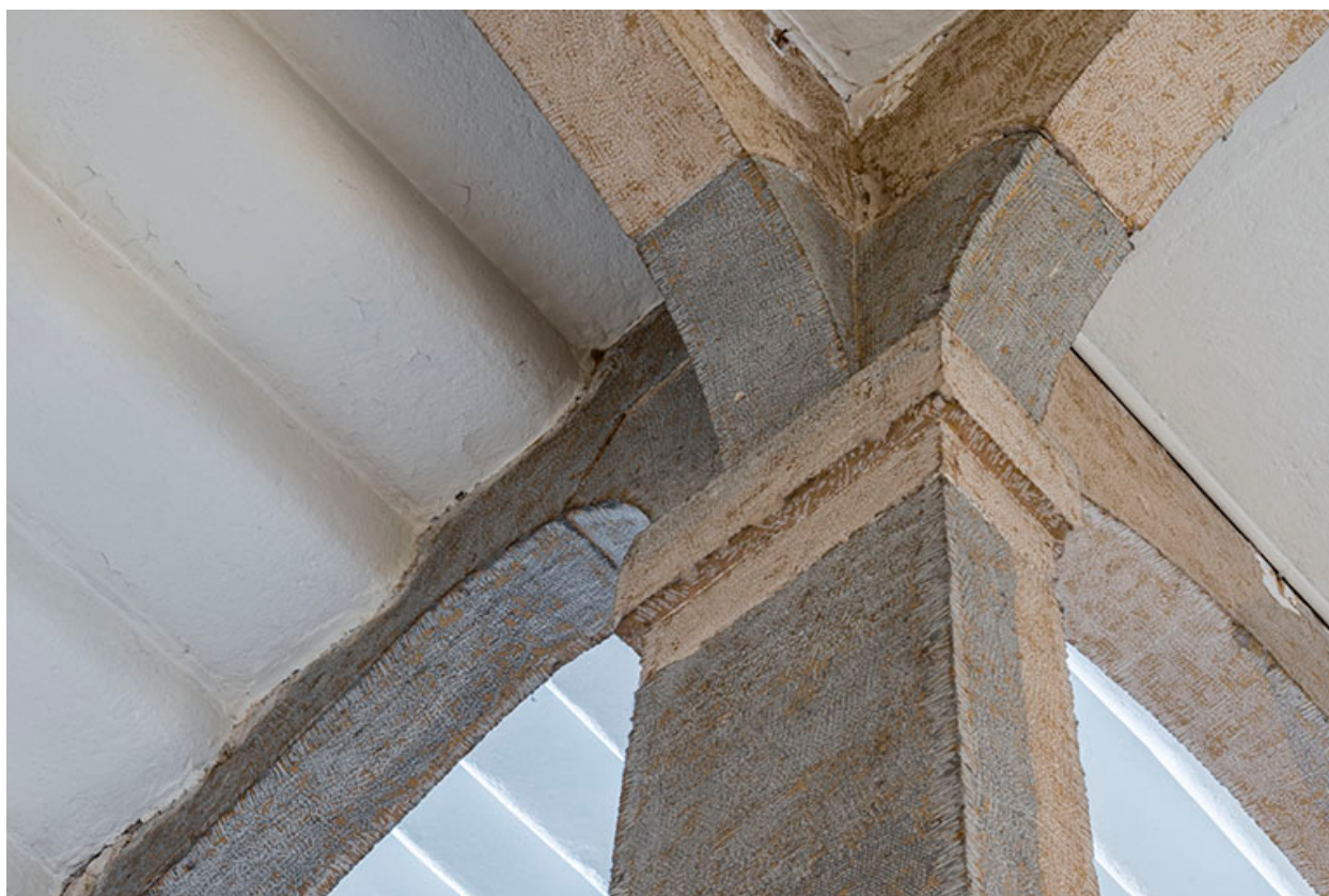
Grand escalier : partie supérieure du premier pilier rectangulaire au rez-de-chaussée, supportant un limon et trois arcs.
