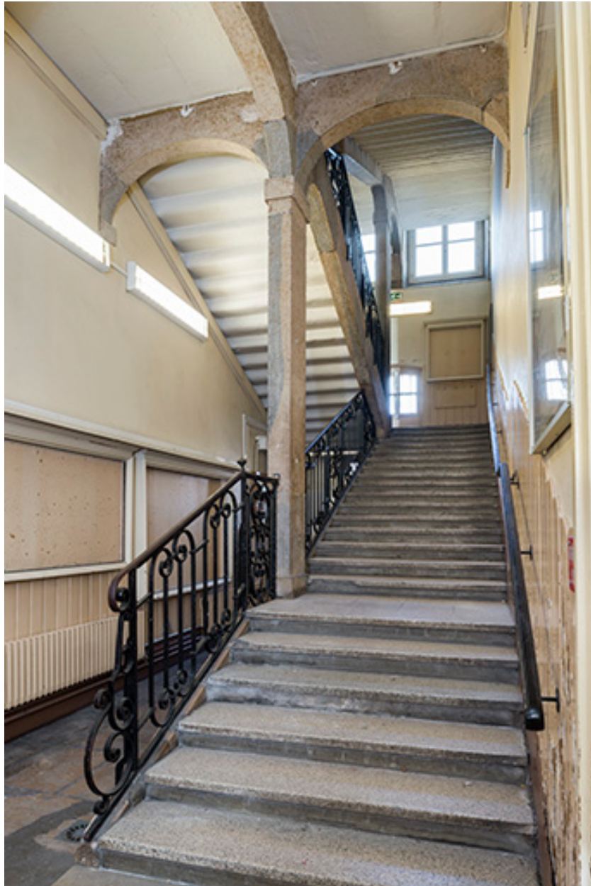
Grand escalier : vue d'ensemble au rez-de chaussée.
