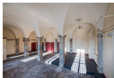
Rez-de-chaussée, partie gauche : pièce voûtée.
