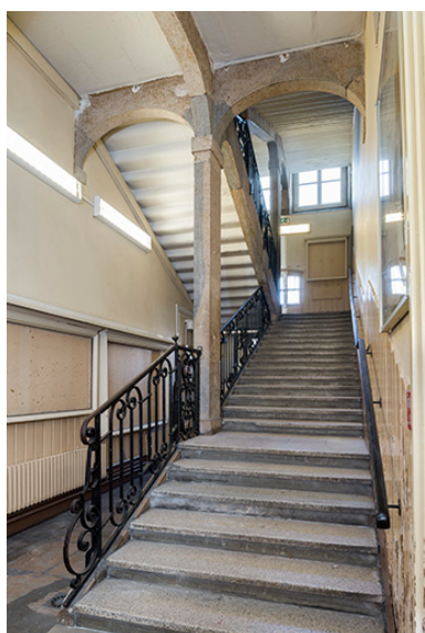
Grand escalier : vue d'ensemble au rez-de chaussée. Phot. Jérôme Mongreville IVR43_20162501449NUC4A
