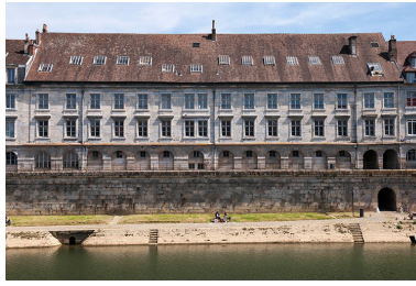
Façade postérieure. Phot. Jérôme Mongreville IVR43_20162501427NUC4A
