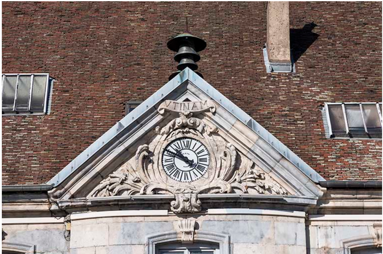
Avant-corps central : fronton.
