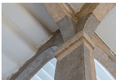
Grand escalier : partie supérieure du premier pilier rectangulaire au rez-de-chaussée, supportant un limon et trois arcs.
