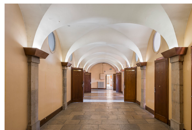
Premier étage, partie gauche : couloir central voûté.
