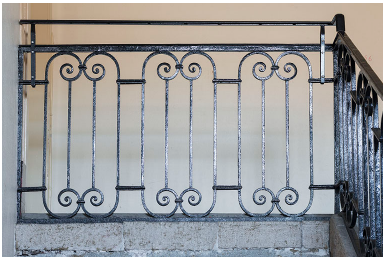
Grand escalier : garde-corps du dernier palier.
