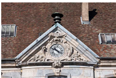
Avant-corps central : fronton. Phot. Jérôme Mongreville IVR43_20162501470NUC4A
