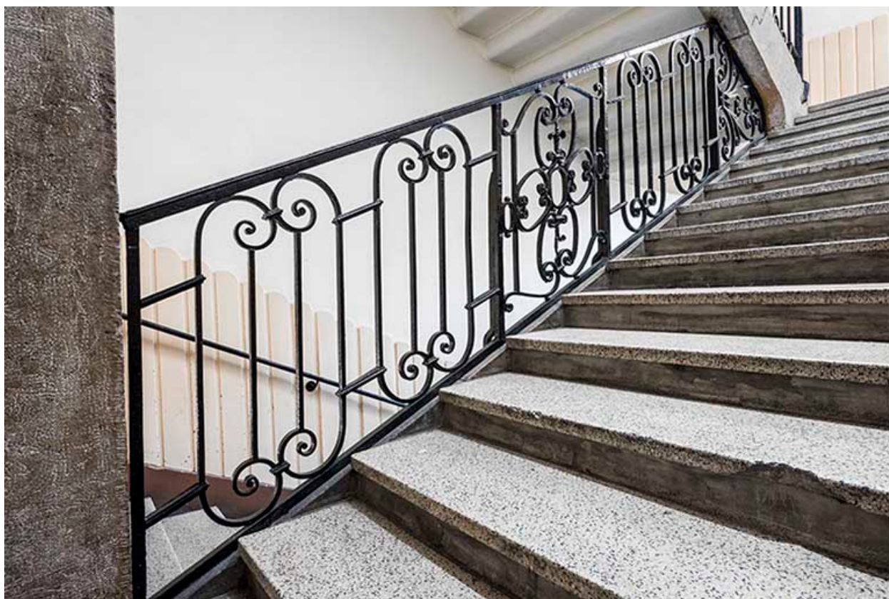
Grand escalier : garde-corps en ferronnerie.
