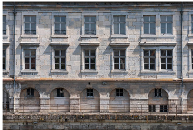
Façade postérieure : partie gauche et travée centrale (marquée par les fenêtres doubles). Phot. Jérôme Mongreville IVR43_20162501429NUC4A
