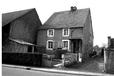
Maison située rue des Vergers. Phot. Bernard Lardière IVR43_19832500359Z
