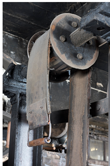
Tambour et courroie de commande. Phot. Sonia Dourlot IVR43_20172501583NUC4A
