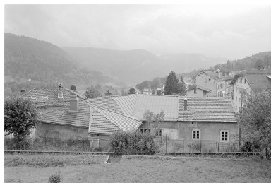
Façade postérieure et toit du bâtiment.
