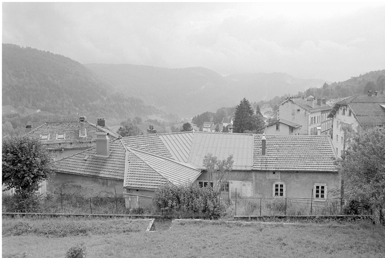
Façade postérieure et toit du bâtiment.
